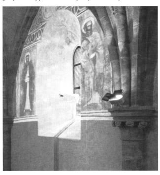
Fig. 5 Dispositif d'éclairage des voûtes (au premier plan sur chapiteau central).
