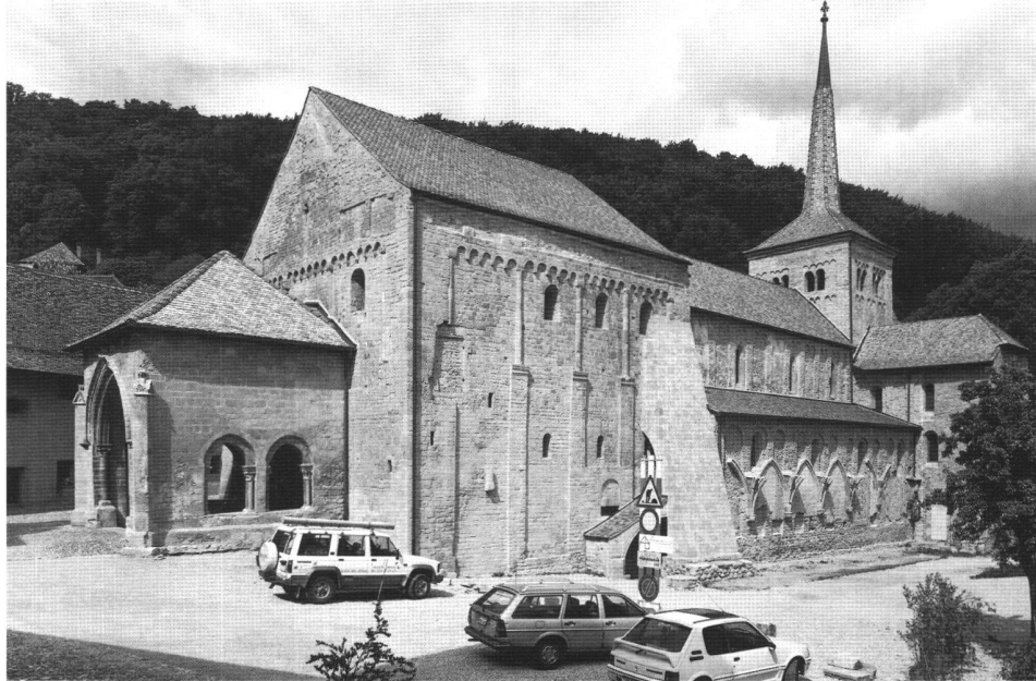
Fig. 2 Vue d'ensemble de l'église du sud-ouest, juste après la fin des travaux de la première étape (façades et toitures). Mis à part la couleur – pour l'instant – plus claire de la toiture, l'extérieur du monument se présente comme avant l'intervention. Les véhicules qui encombrant encore les abords de l'édifice laisseront très prochainement place à des aménagements extérieurs rappelant l'emplacement du cloître et des bâtiments conventuels.
