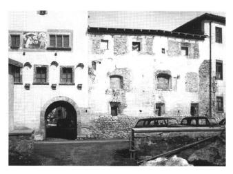
Abb. 8 Müstair, Kloster St. Johann. Südtrakt, Fassade nach der Untersuchung. Fenster aus dem 19. Jahrhundert sind zugemauert, ältere wieder geöffnet.
