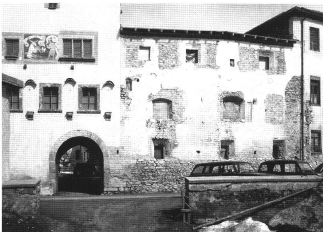
Abb. 8 Münstair, Kloster St. Johann. Südtrakt, Fassade nach der Untersuchung. Fenster aus dem 19. Jahrhundert sind zugemauert, ältere wieder geöffnet.
