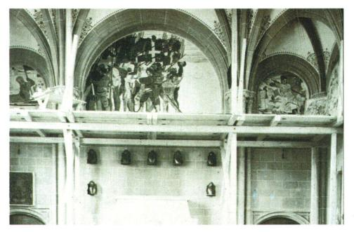
Abb. 2 Ausschnitt aus einer historischen Fotographie von 1899/1900 (Brüschweiler Archiv). Sie zeigt das Malergerüst, auf dem Hodler während der Ausführung des mittleren Wandbildes von links nach rechts gearbeitet hat.
