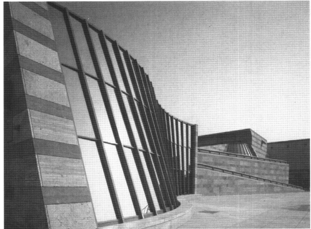
Bild D Staatsgalerie in Stuttgart, Neubau.
