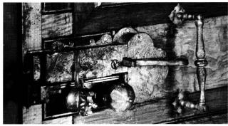
Abb. 7 Schloss an der Eingangstür mit dem den Mechanismus abdeckendem Gehäuse; Kapelle und Nachtriegel.
