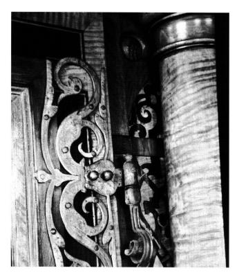
Abb. 6 Scharnierbeschlag der Eingangstür.
