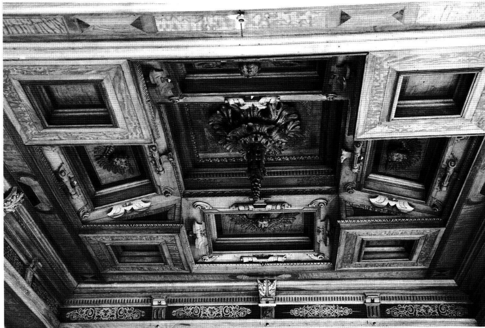
Abb. 26 Zentrale Hauptkassette der Decke.
