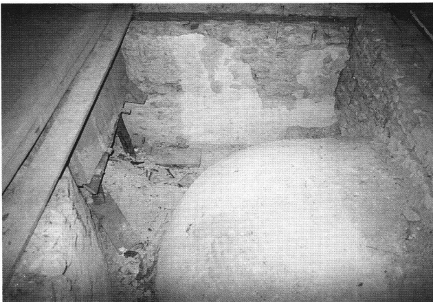
Abb. 13 Dachraum über der südlichen Seitenschiffapside (Aufnahme 1985).
