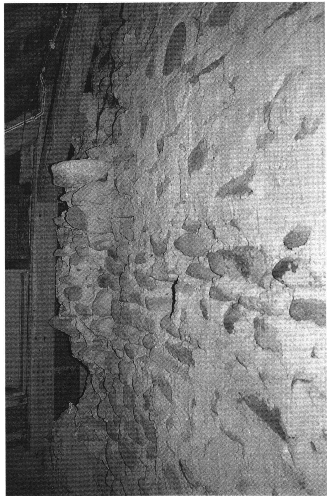
Abb. 20 Dachraum über dem nördlichen Seitenschiff: Nördliche Hochschiffwand des Langhaus-Mittelschiffes und Ansatzstelle (Abbruchrest) der Westmauer des ehemaligen nördlichen «Querhauses» (Aufnahme 1980).
