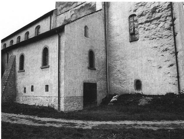
Abb. 12 Südliche Abseite von Südosten gesehen (Aufnahme 1983).
