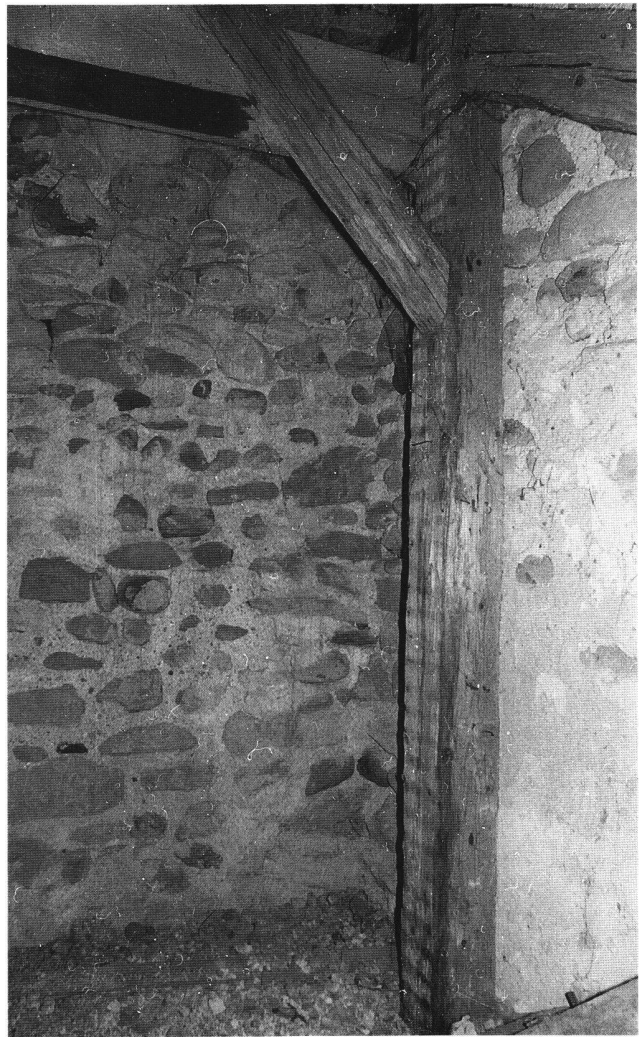
Abb. 34 Nordosteck vom Dachraum des südlichen «Querhauses» (Aufnahme 1980).
