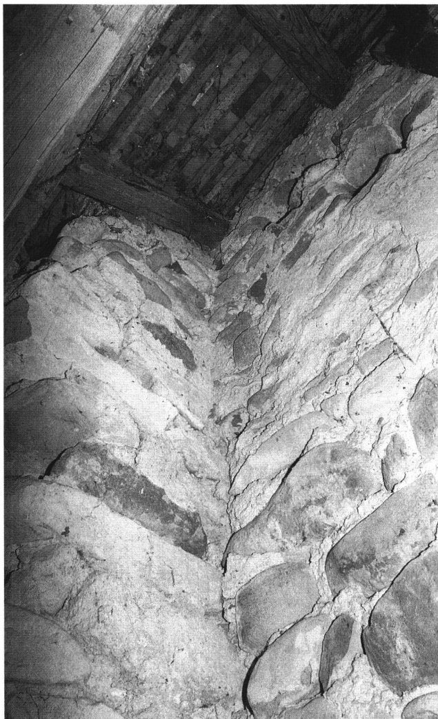
Abb. 35 Ansatzstelle der abgebrochenen ehemaligen Westmauer des südlichen «Querhauses» mit der Südmauer des Turmjoches (Aufnahme 1980).
