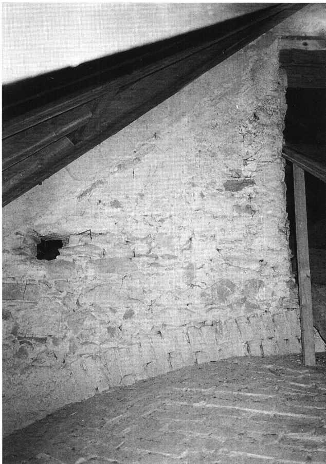
Abb. 30 Giebelige Stirnmauer der Westwand des Langhaus-Mittelschiffs oberhalb der Kalotte der Westapsis (Aufnahme 1993).
