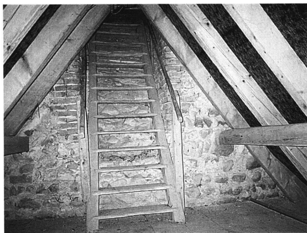
Abb. 32 Dachbodentreppe über der Kalotte der Westapsis (Aufnahme 1993).
