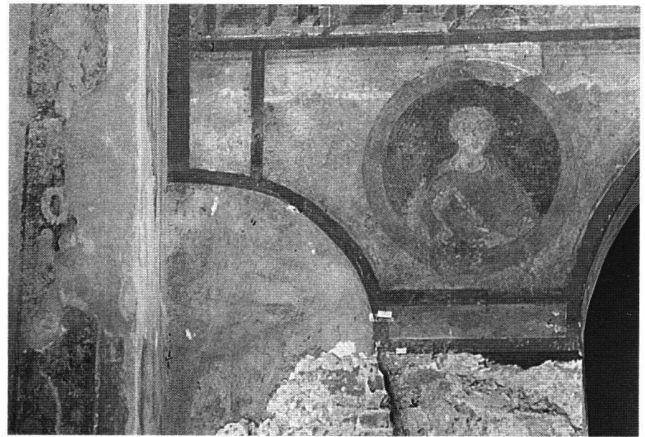
Abb. 24 Nördliche Antenzone vor der westlichen Triumphbogenwand mit dem vorübergehend freigelegt gewesenen «Halbbogen» (Aufnahme 1985).
