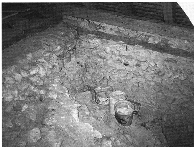
Abb. 36 «Opus spicatum»-artiges Mauerwerk, das die erneuerte Nordmauer der nördlichen Abseite anschliesst (Aufnahme 1993).
