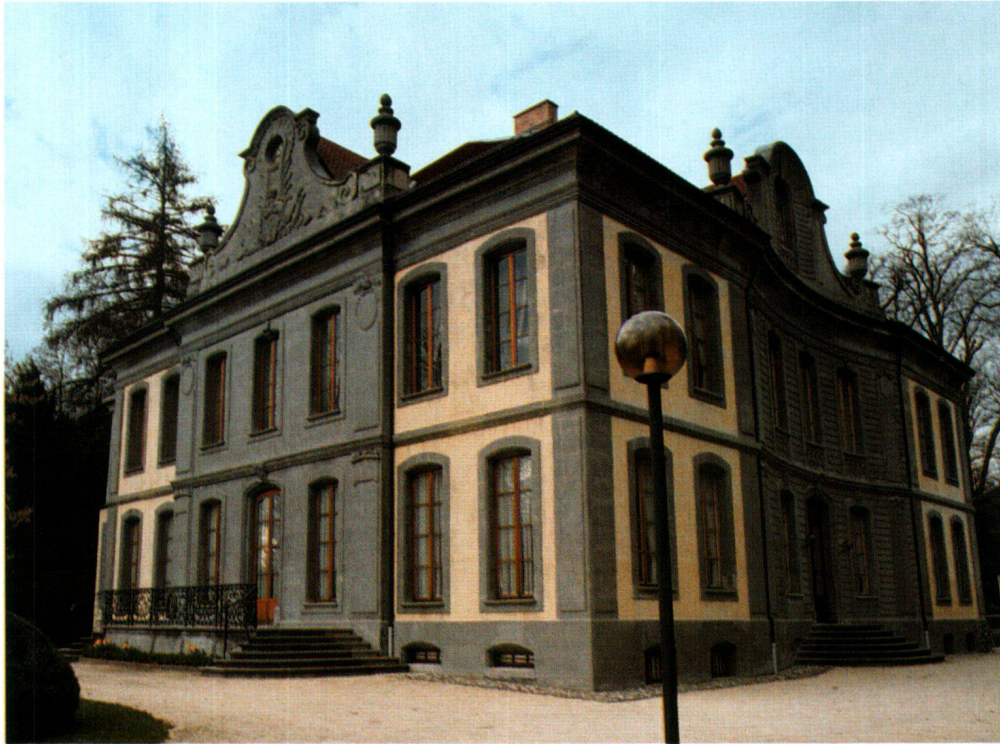
Fig. 4 L'Elysée (Lausanne). Les couleurs d'origine des façades ont été rétablies en 1979. On remarquera que les avant-corps, entièrement en pierre appareillée, sont uniformément badigeonnés en gris foncé, une couleur très répandue aux XVII e et XVIII e siècles, alors que, sur le reste des façades, les parties crépies badigeonnées en jaune contrastent avec le gris appliqué sur la pierre.
