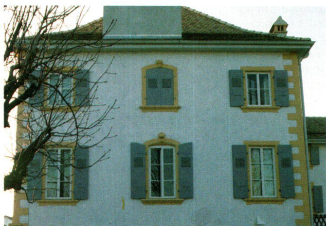
Fig. 6 Au château de Préverenges la peinture d'une fausse fenêtre à l'emplacement occupé par les conduits de fumée a permis d'assurer la régularité de la façade.
