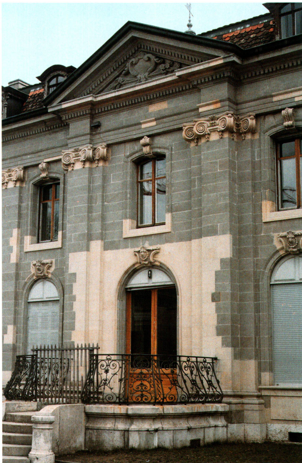
Fig.9 La Grande Boissière (Genève), avant-corps central de la façade ouest. Une restauration comme on les pratiquait dans les années 50-60: les façades ont été entièrement ravalées et de nombreux quartiers remplacés par des pierres d'une autre couleur.
