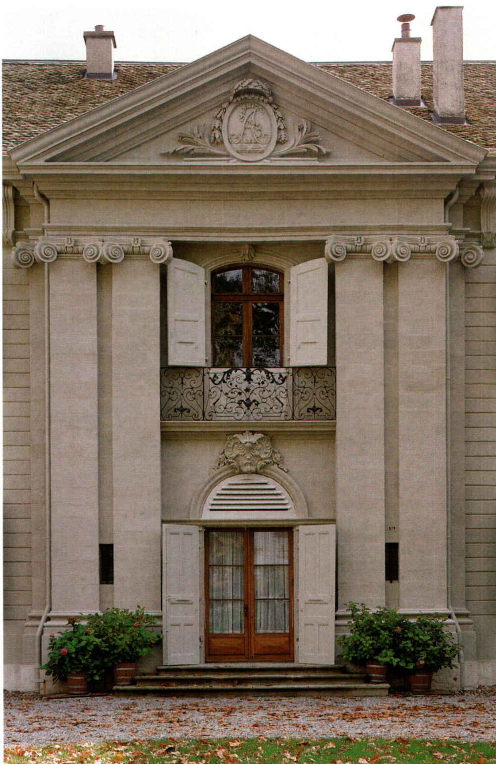
Fig. 10 Château de Crans (Vaud), avant-corps central de la façade sur cour. Pour unifier l'aspect des façades, auxquelles les réparations successives avaient donné un aspect «bigarré», et pour protéger la pierre, nous avons utilisé une peinture minérale Sax-Hydrosil avec glacis. Ce traitement unifié doit permettre une bonne lecture de la composition des façades.
