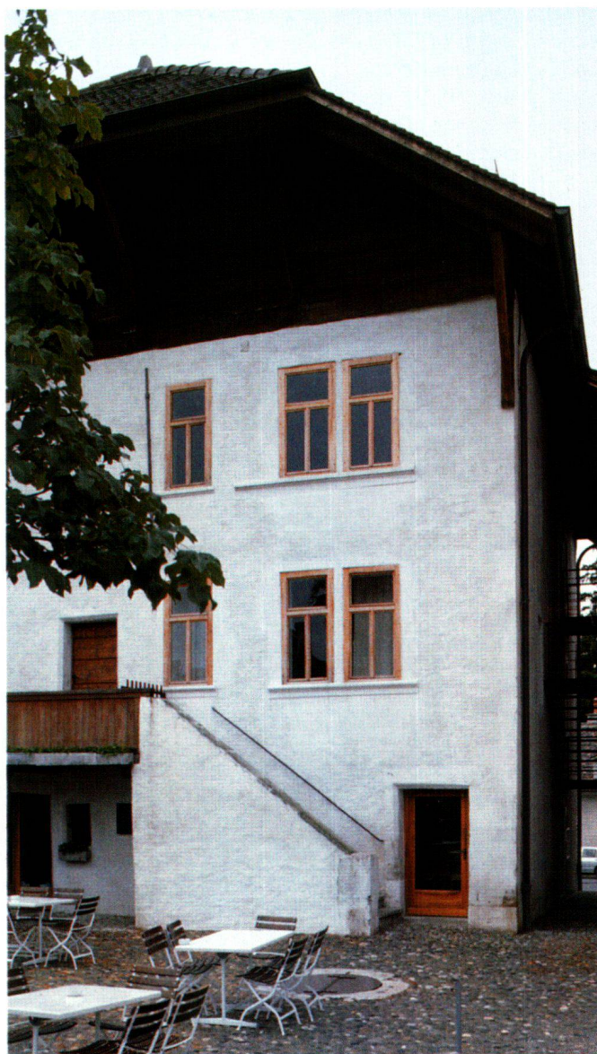
Fig. 3 Le château de Genthod (Genève), devenu Mairie en 1978, possède encore des fragments d'un crépi à faux-joints typique du XVII e siècle; ceux-ci ont été consolidés et l'ensemble des façades, soit crépi et pierre de taille (molasse), a été blanchi à la chaux, un traitement qui semble avoir été fréquent autrefois.
