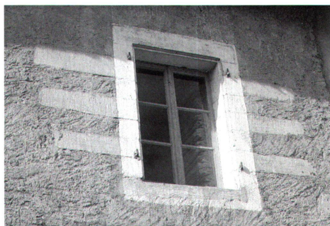
Fig. 7 Encadrement de fenêtre en molasse peint en blanc, couleur du calcaire de qualité du Jura proche de Genève. On notera que la largeur de l'encadrement est régulière et que les « queues » des pierres d'encadrement intégrées dans la maçonnerie sont peintes dans la couleur du crépi, comme c'en était l'usage.
