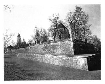
Fig. 10 Vue du Bastion de St-Ours prise du nord-est, avec la tour d'artillerie du Riedholz en arrière et la fausse-braie et le fossé au premier plan.
