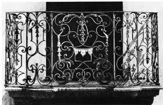
Fig. 4 Lugano. Balcone in ferro battuto dell'antica casa Castagna. - Evidenti, come nella Fig. 2, i singoli elementi riferibili alla proposta del Bérain (Fig. 3).
