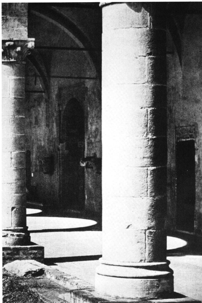
Fig. 10 Pavia. Castello Visconteo. Base delle colonne del cortile.
