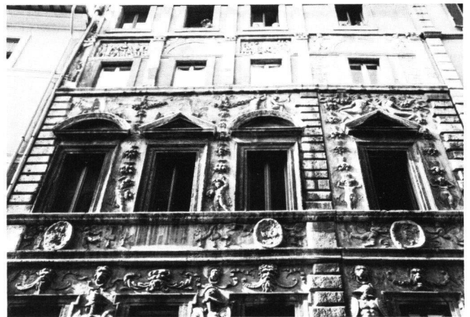
Fig. 8 Roma, casa Crivelli, la facciata.
