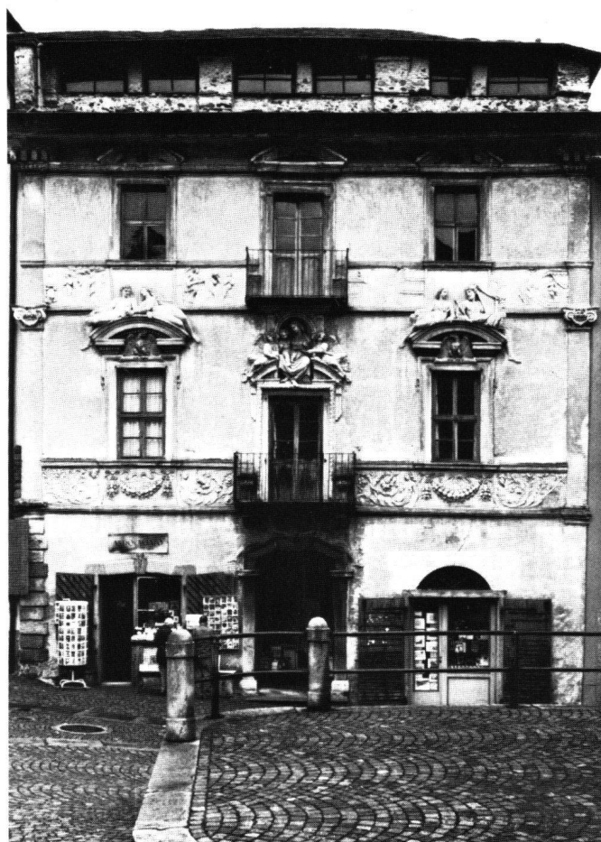
Fig. 1 Ascona, la facciata di casa Serodine.
