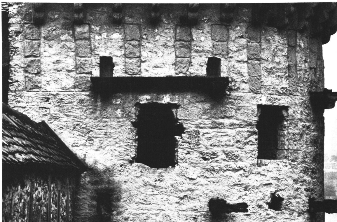
Fig. 2 Château de Chillon, détail du couronnement primitif de la tour Z présentant une série de trous de poutre qui devaient recevoir à l'origine les supports de hourds en bois; il est ajouré de baies-crèneaux à l'inteau sur coussinets (Photo: Daniel de Raemy).
