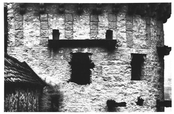
Fig. 2 Château de Chillon, détail du couronnement primitif de la tour Z présentant une série de trous de poutre qui devaient recevoir à l'origine les supports de hourds en bois; il est ajouré de baies-créneaux à l'inteau sur coussinets (Photo: Daniel de Raemy).
