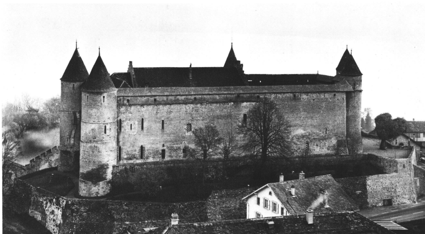
Fig. 6 Château de Grandson, vu du nord. A gauche, l'extension orientale, le «carré savoyard» de 1278-80, flanqué de trois tours circulaires; la façade nord est ajourée de baies-lancettes très allongées. Au centre la façade subsistante du donjon roman avec sa porte haute. A droite, l'extension occidentale du début du XIV e siècle avec ses deux tours semi-circulaires dont la façade nord a été reconstruite tardivement au XIV e siècle (Photo: Claude Bornand).
