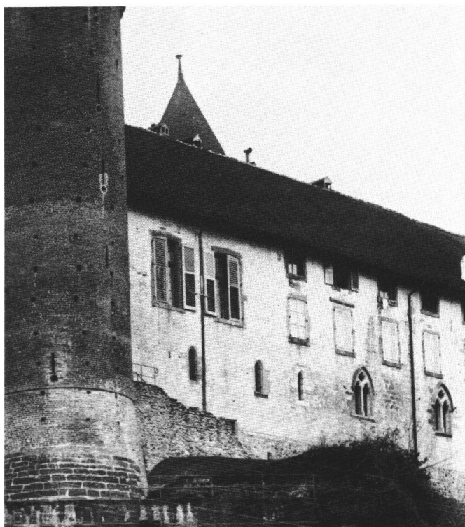
Fig. 13 Estavayer, château de Chenaux, façade nord-ouest ajourée de baies-lancette du même type que celles de Grandson (quoique plus courtes) et de baies géminées surmontées d'un oculus; pour ces dernières, seule la modénature du larmier en arc brisé et des impostes des montants de la baie peut être comparé aux baies de ce type que l'on observe au château de Grandson. Comme à Grandson d'ailleurs, le remplage et le meneau ont été intégralement restitué par Otto Schmid en 1916 (Archives fédérales des Monuments Historiques, Photo Macherel, 1921).
