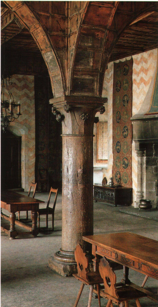
Fig. 4 Château de Chillon, salle Q, colonne en chêne surmontée d'un chapiteau à crochets (Photo: E. Vogt).
