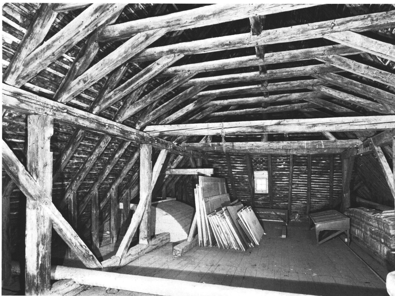
Fig. 14 Château d'Yverdon, charpente de l'aile orientale de 1503, en forme de «carène de navire inversée», état avant les travaux de restauration de la chapelle en 1982 (Photo: Fibbi-Aeppli).
