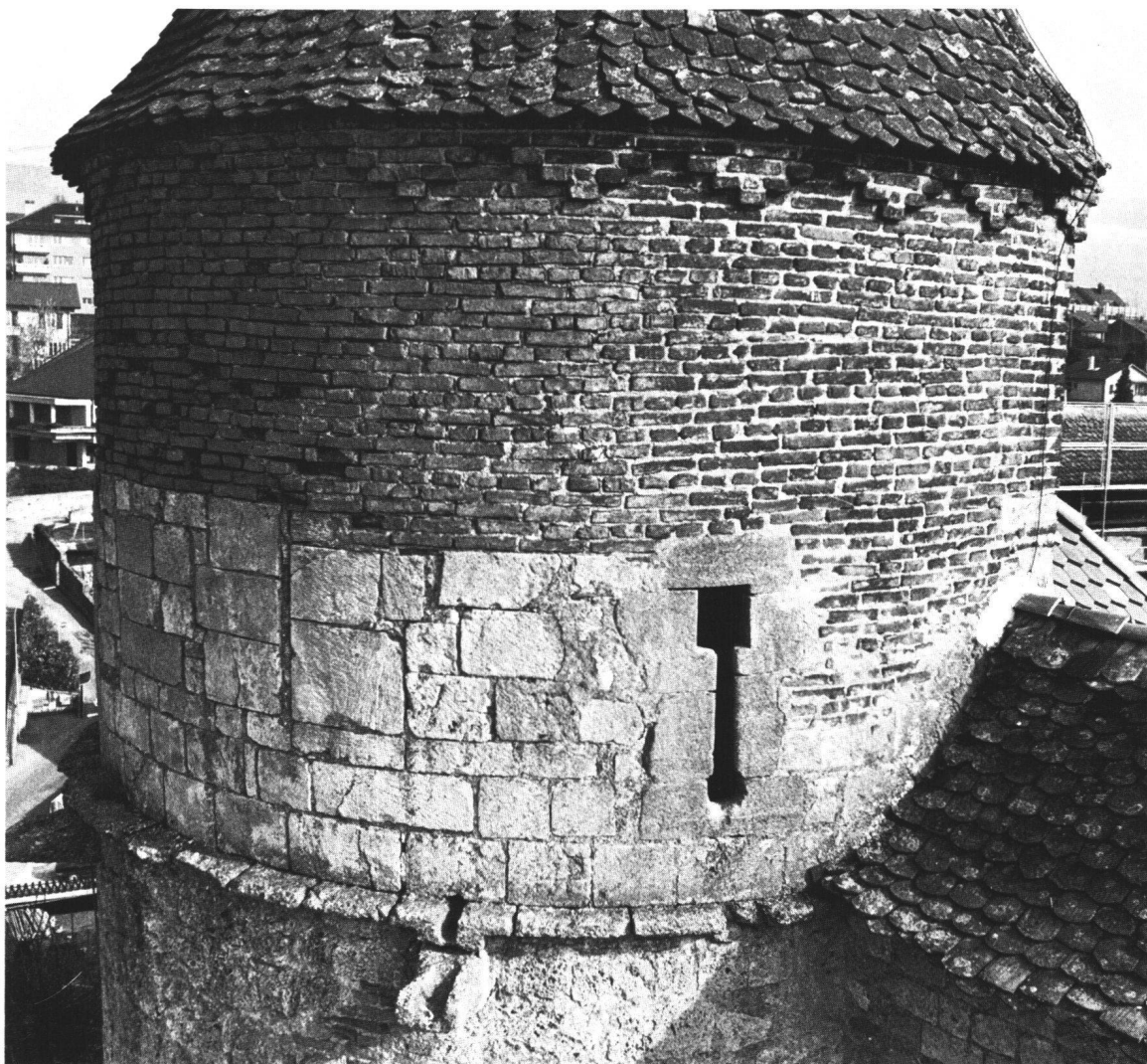
Fig. 11 Château de Grandson, tour semi-circulaire sud, reste d'un percement de guet (ou archère?) ajourant le couronnement primitif en appareil de calcaire jaune de Hauterive ou de la Sarraz (Photo: D. de Raemy).
