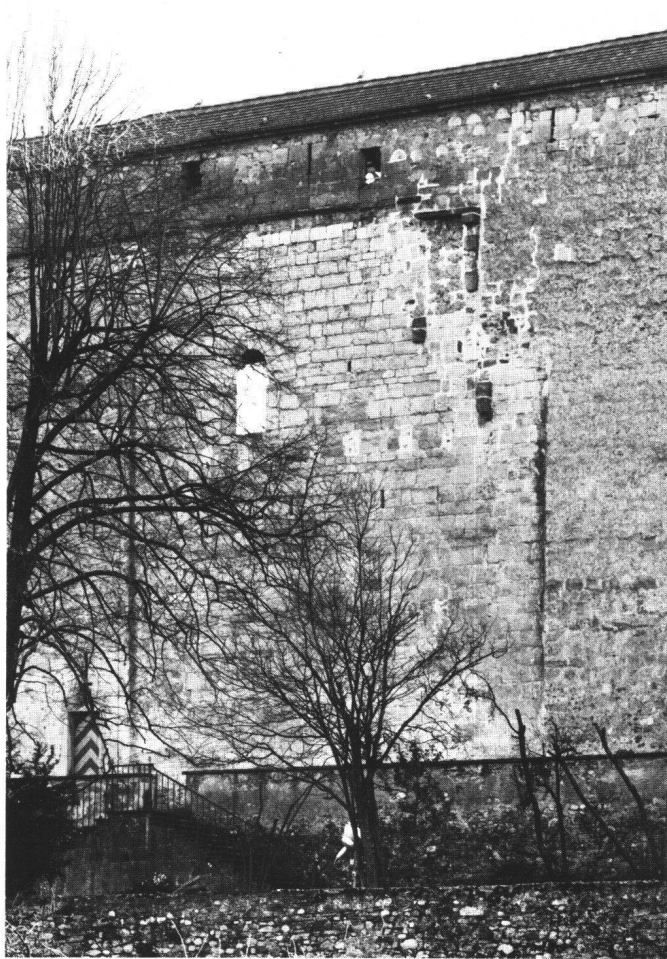
Fig. 7 Château de Grandson, façade nord du donjon roman; la partie supérieure de l'angle ouest du donjon a reçu à l'époque de la construction du «carré savoyard» une latrine et une échauguette ou une tourelle-escalier à vis dont subsiste encore l'arrachement (Photo: Claude Bornand).
