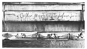
Abb. 10 Stubenofen im Haus R. Sch., in Hirzel, Dorf. Kranzkachel mit der Inschrift «Casper Margstaller Hafner jn / Ebertschweill 1813». Der Stab weiss glasiert mit blau gemaltem Strichdekor. Die Füllkacheln glatt und grün glasiert.
