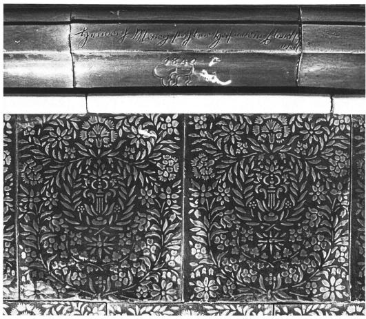
Abb. 11 Stubenofen im Haus E.B., in Heisch bei Hausen am Albis. Kranzkachel mit der Inschrift «Heinrich Margstahler Hafner in Ebertschweil/1840». Der Stab weiss glasiert ohne Dekor. Die Füllkacheln mit patroniertem Muster, hell- und dunkelgrün glasiert.
