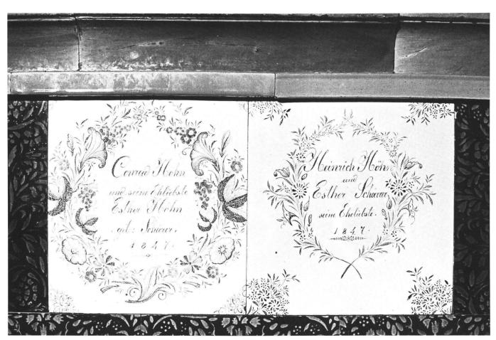
Abb. 14 Schmuckkacheln eines Stubenofens im Haus A.R., «Wesenmatt» bei Hausen am Albis. Die hell- und dunkelgrün glasierten Füllkacheln mit patroniertem Nelkenmuster deuten auf die Werkstatt von Heinrich Margstahler in Ebertswil. Der Stab ist glatt und hellgrün glasiert.
