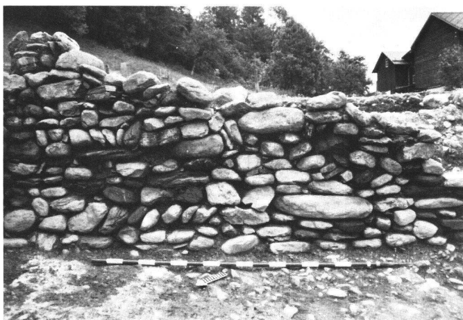
Abb. 25 Schiers-Chrea 1986, Ostmauer des Grubenhauses, M 25a, Ansicht von Westen, schön geschichtete Mauerstruktur.
