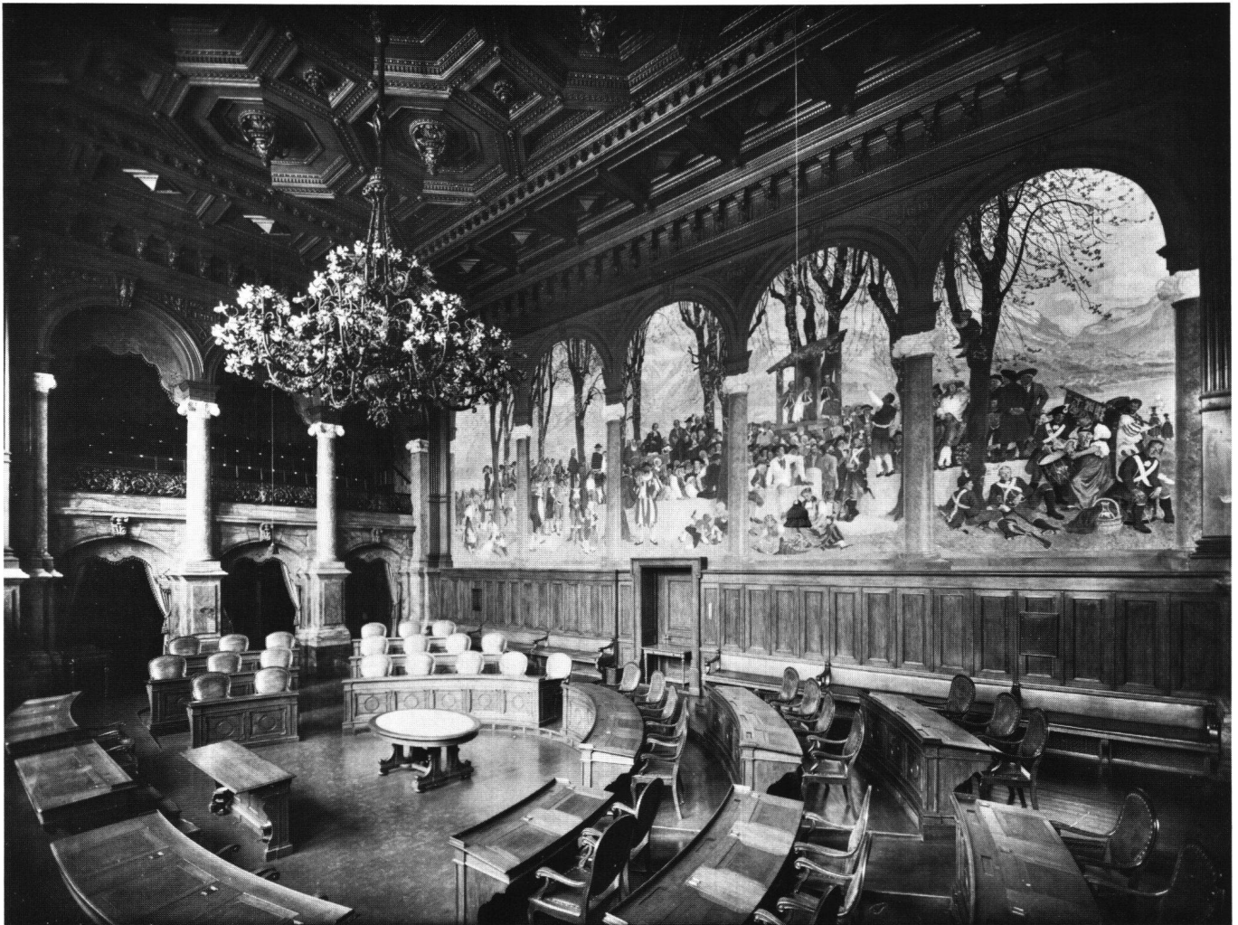
Abb. 26 Ständeratssaal mit dem Wandbild «Die Landsgemeinde» von Albert Welti und Wilhelm Balmer, 1908-14.
