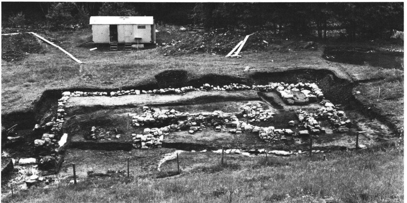
Glashütte Südel im Entlebuch, 1723–60. Blick von Westen auf das Grabungsgelände. Gut sichtbar sind die drei Fundamentmauern der im Grundriss rechteckigen Glashütte, der von rechts, vom Bach her, nach links in ein Reservoir verlaufende Wasserkanal im Vordergrund, der Glashafen-Vorwärmofen in der rechten oberen Ecke der Hütte, der Holzdörfen an der Aussenmauer der Hütte und der rechteckige Schmelzofen im Zentrum mit den seitlich angefügten Kühlöfen, deren Fundationsmauern diagonal auseinanderstreben. Der Blick geht vom höheren, sonnigeren Plateau, wo das Glasmeisterdörfchen stand, auf den Produktionsplatz und den Bach im Hintergrund.
