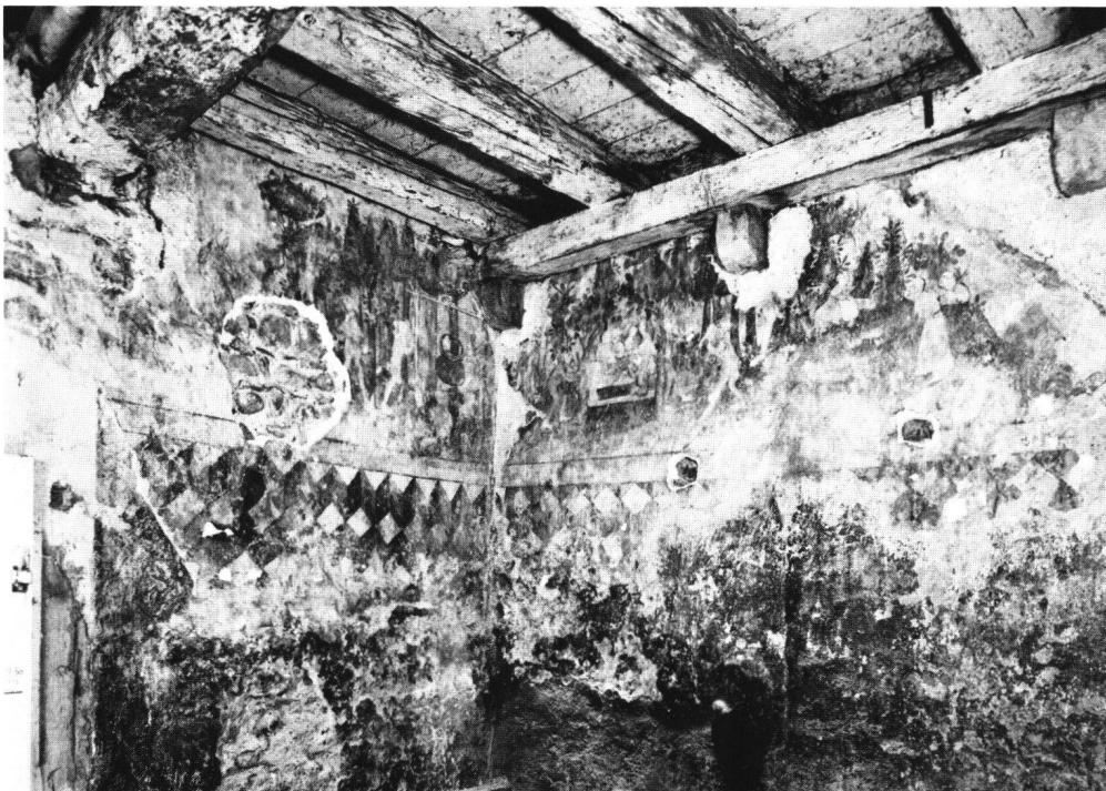
Abb. 1 Blick in die Südwestecke des Erdgeschossraumes mit dem Wildleutegemälde. Links die Südwand (es fehlt der linke Abschluss), rechts die Westwand (abgeschlossen mit Treppenschräge).
