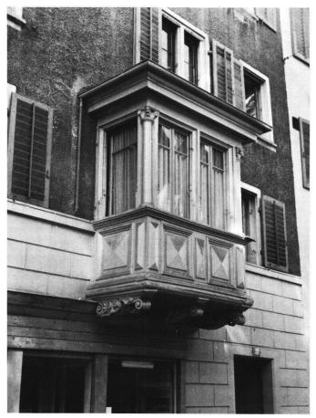
Abb. 15 Rechteckiger Erker auf drei geschnitzten Konsolen mit Voluten und Blattwerk. Die beiden Ecken werden durch korinthische Säulen über Sockeln ausgezeichnet. Die Brüstungsfelder weisen facettierte Quader auf. 2. Hälfte des 17. Jahrhunderts.
