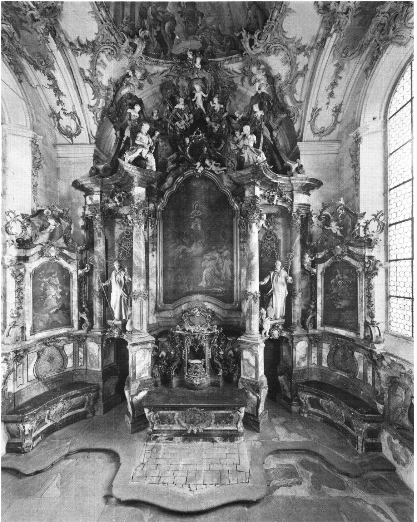
Abb. 2 Photogrammetrisches Messbild des Hochaltars vor der Restaurierung. Verzeichnungsfreie Aufnahme mit Präzisionskamera Wild P 31/45.
