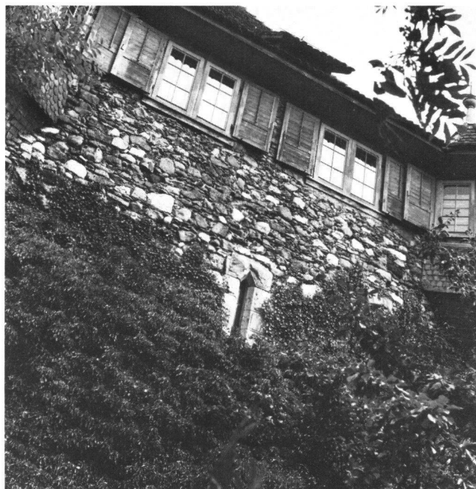
Abb. 8: «Hardturm» (Hardturmstrasse 136): Das mit dem Turmganzen im Verband stehende Licht gehört in die zweite Hälfte des 13. Jahrhunderts.
