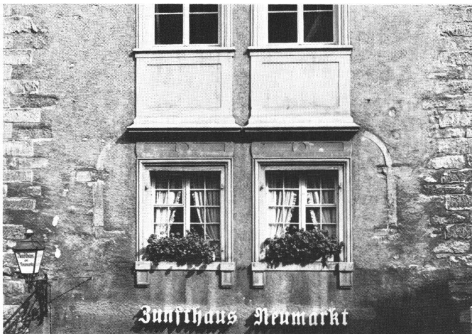
Abb. 18: «Bilgeriturm» (Neumarkt 5): Bei der meist gleichbleibenden Geschosseinteilung sind die Verluste an mittelalterlichen Fenstern – wie hier zwei spätromanische Biforen – die durch jeweils jüngere, grössere Ausbrüche entstanden, nicht quantifizierbar.
