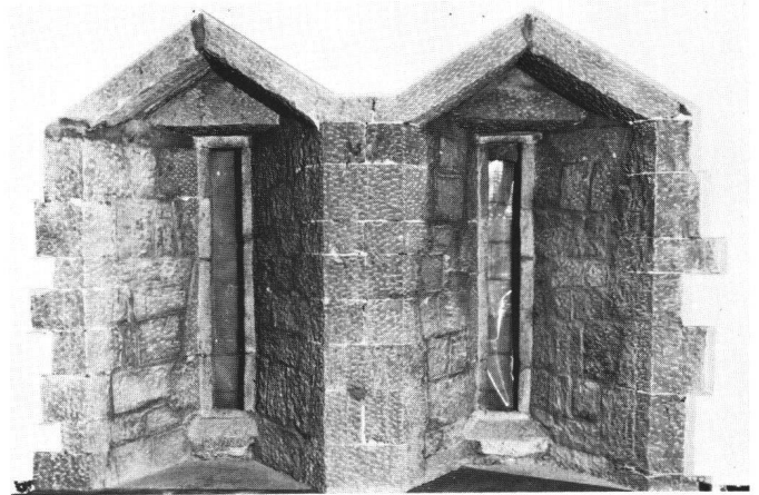
Abb. 10: «Zum Oberen Kürass» (Augustinergasse 21): Gewände, Sturz und Bank sowie die tiefe Nischenleibung sind aus sorgfältig bearbeiteten Sandsteinquadern gefügt.
