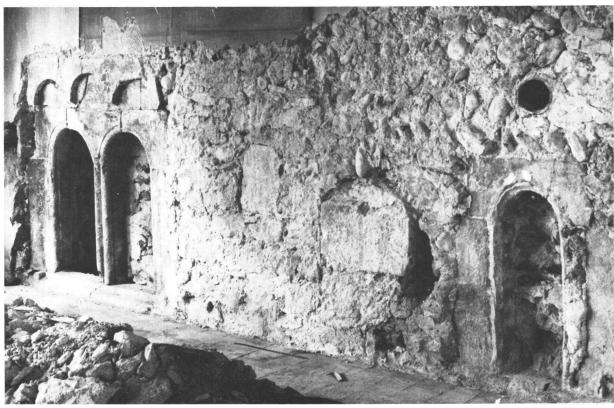
Abb. 16: «Zum Schwanen» (Münstergasse 9): dieser monumentenarchäologische Befund wurde 1947 erhoben. Das gekuppelte Fenster mit dem Halbrundstab unter einem Blendbogenfries ist heute in Zweitverwendung im Erdgeschoss eingebaut.
