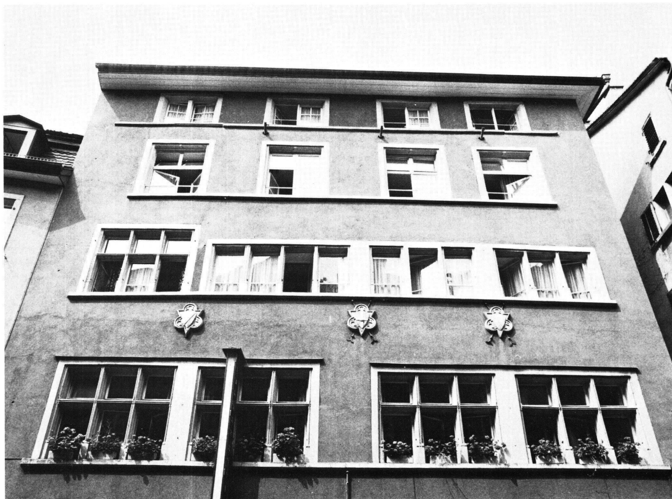
Abb. 26: «Zum Roten Haus» (Marktgasse 17): Die zwei Dreiergruppen von 1576 mit Kreuzstöcken im ersten Obergeschoss sind die am «reichsten» (!) profilierten Fenster des 16. Jahrhunderts in Zürich: Wandung und Pfosten sind doppelt gekehlt und mit Renaissancevoluten versehen.
