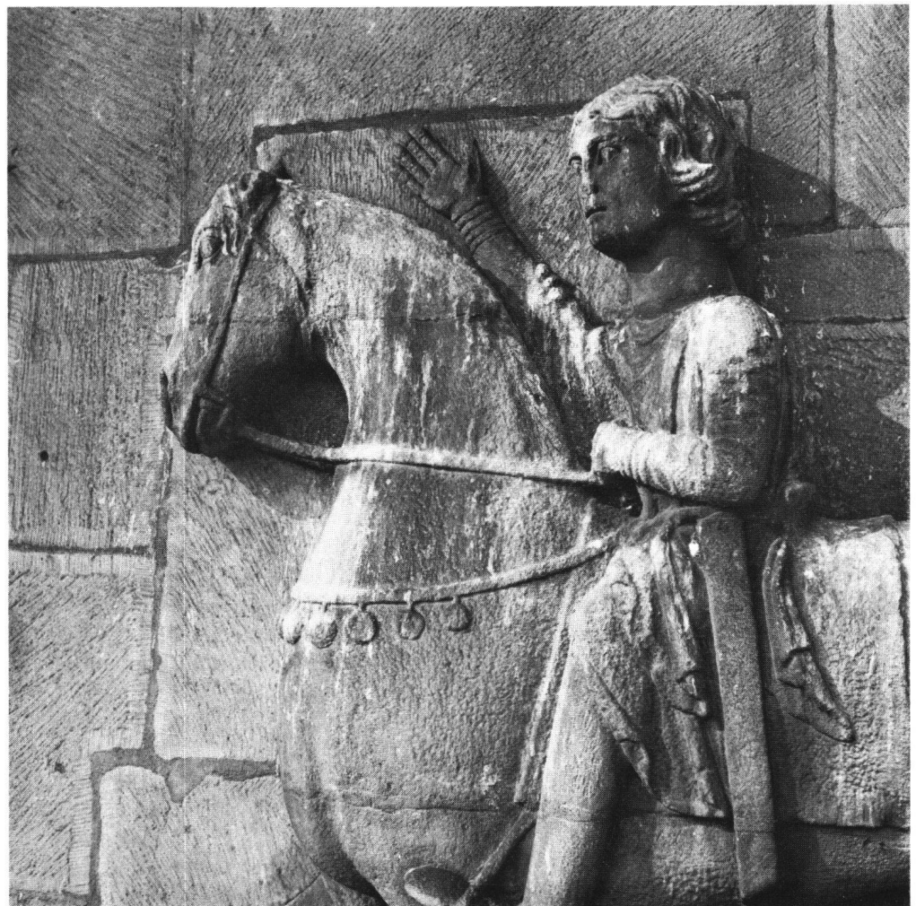
Der Reiter am Grossmünster, Ausschnitt. Intensive Beschmutzung der von Vögeln benutzten Sitzflächen. Ausser bekannten Absplitterungen (Nase und Daumen des Reiters, Pferdeohr) keine Verwitterungsanzeichen erkennbar. (Aufnahme K. Zehnder, 10. Mai 1979).
