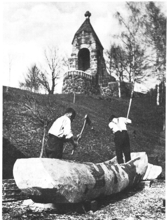
Abb. 4 Fischer beim Höhlen eines Einbaumes mit Axt und Querbeil. Ägerisee, um 1934. – Im Voralpenraum entstanden Einbäume aus mächtigen Weißtannen, sogenannten Schiffstannen. In tieferen Lagen bevorzugte man Eichenstämmen. – Im Hintergrund das Denkmal, welches 1906 zur Erinnerung an die Schlacht bei Morgarten errichtet wurde.
