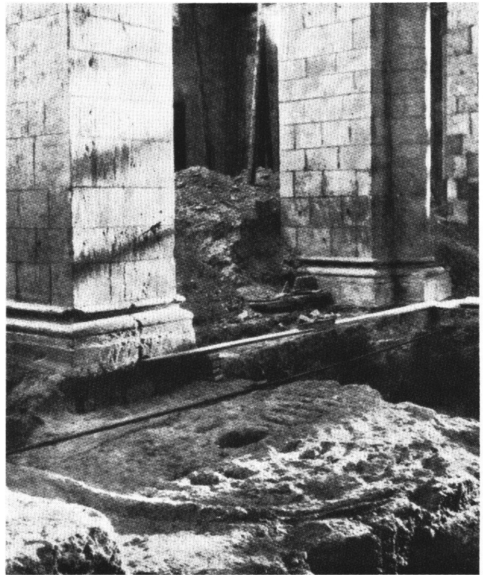
Abb. 13 Mönchengladbach. Ansicht der Mörtelscheibe von Südwesten. Besonders auffällig sind hier die konzentrischen Wellen.
