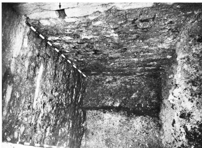
Abb. 37 Schaffhausen I. Clastrum. Latrine im Osten des Südtraktes, gesehen von Norden nach Süden. Der Pfeil bezeichnet die Öffnung, in welcher ein Träger der Holzkonstruktion des Bodens der Latrine eingesetzt war.
