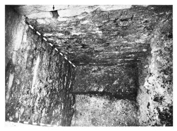
Abb. 37 Schaffhausen I. Claustrum. Latrine im Osten des Südtraktes, gesehen von Norden nach Süden. Der Pfeil bezeichnet die Öffnung, in welcher ein Träger der Holzkonstruktion des Bodens der Latrine eingesetzt war.
