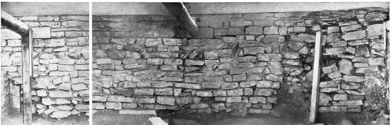
Abb. 66 Eingezogene Zwischenwand in der Krypta von Schaffhausen Ic. Ansicht von Westen.
