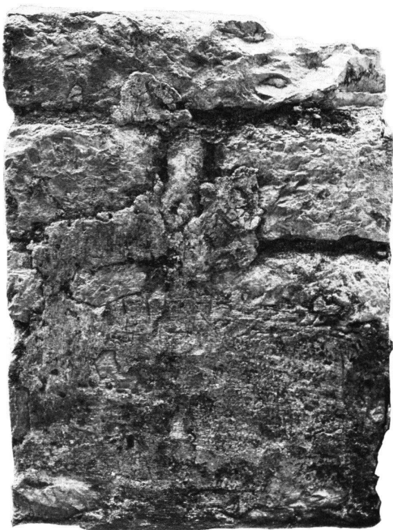
Abb. 57 Schaffhausen Ic. Krypta. Pfeiler beim Eingang. Verputzter Kalkstein.
