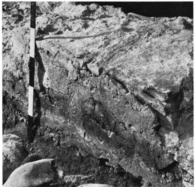
Abb. 51 Schaffhausen Ib. Kirche. Innenseite der gestelzten Apsis. Weißliche Feinschicht oder Schlämme als Rest des Verputzes.
