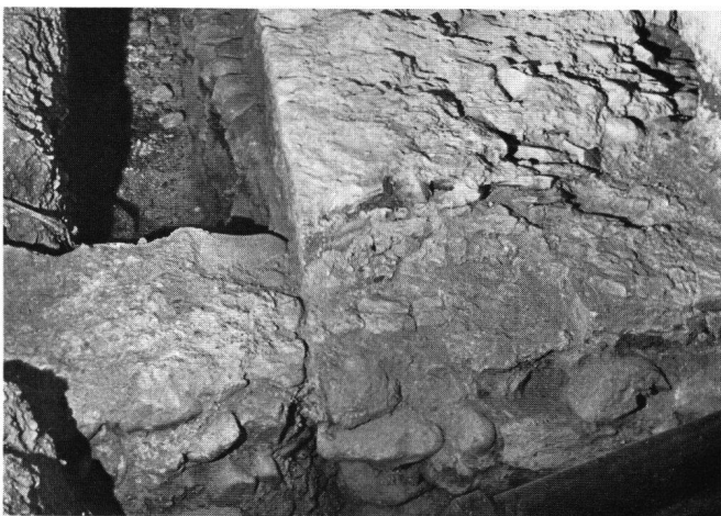
Abb. 32 Schaffhausen I. Turmfundament Süd. Links die Baufuge der Südmauer des Atriumhofes.
