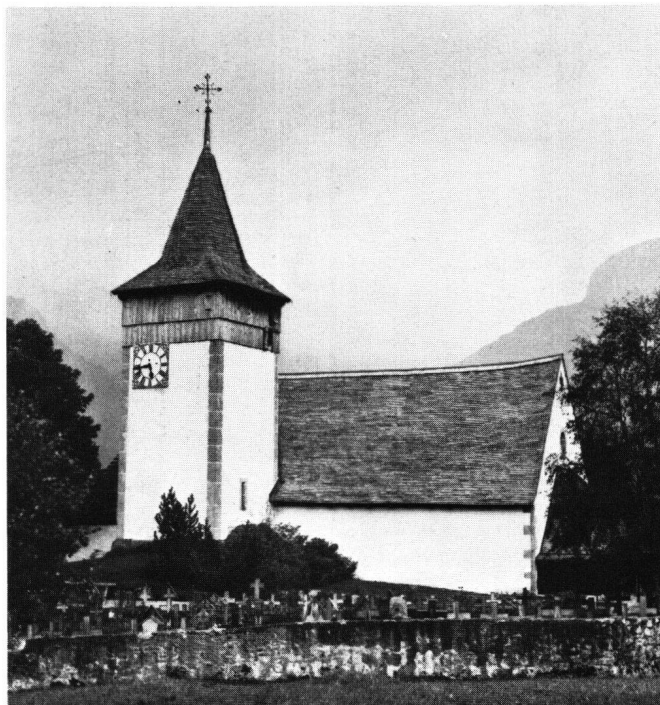
Abb. 17 Kirche Lauenen. Im Turm sind Balken mit Schlagjahren von 1532, 1605, 1738, 1800 und heute vertreten.
