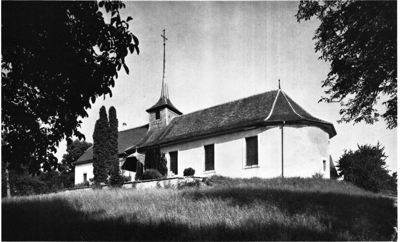
Fig. 3 L'église de Tours et la cure, vue vers le nord-ouest
