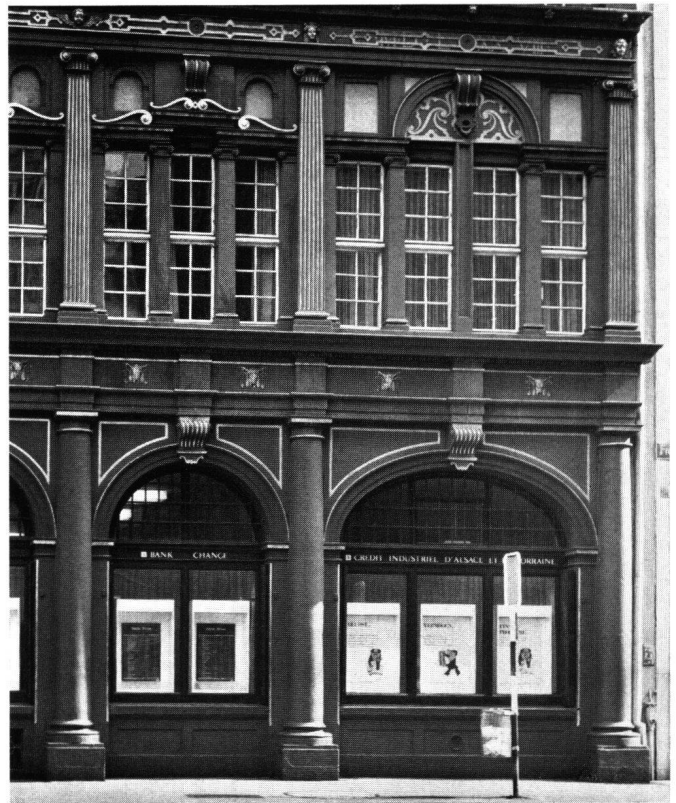
Abb. 10 Basel, Geltenzunft, Detail der Fassade
