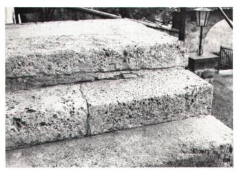
Abb. 2 Außentreppe aus Rauhwacke der Kirche Saanen. Die Verwendungsart zeugt für die Festigkeit und Beständigkeit des grobzellig-löcherigen Gesteins
