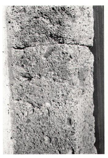
Abb. 4 Detail des Portalgewändes aus Rauhwacke am Turm des Schlosses Spiez. Typisch die zellige Struktur der hier ausnahmsweise wenig gelben Oberfläche
