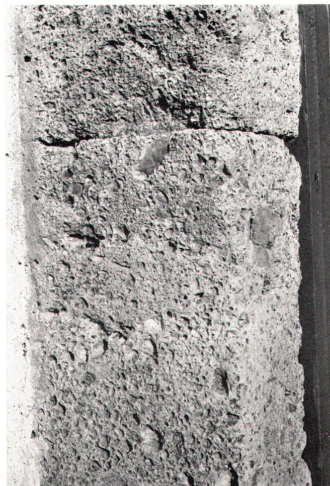
Abb. 4 Detail des Portalgewändes aus Rauhwanke am Turm des Schlosses Spiez. Typisch die zellige Struktur der hier ausnahmsweise wenig gelben Oberfläche
