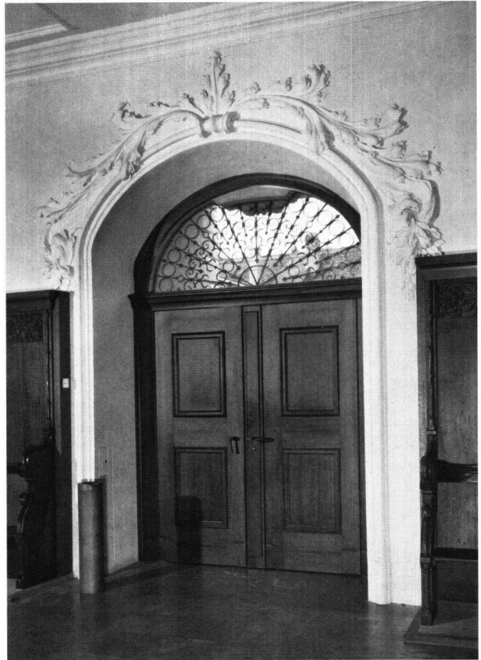
Abb. 47 Neugestaltetes Portal, dessen Aufteilung in Friesen und Füllungen der ursprünglichen entspricht. Als Entwurfshilfe für die Supraporte diente ein Stich von D. Herrliberger
