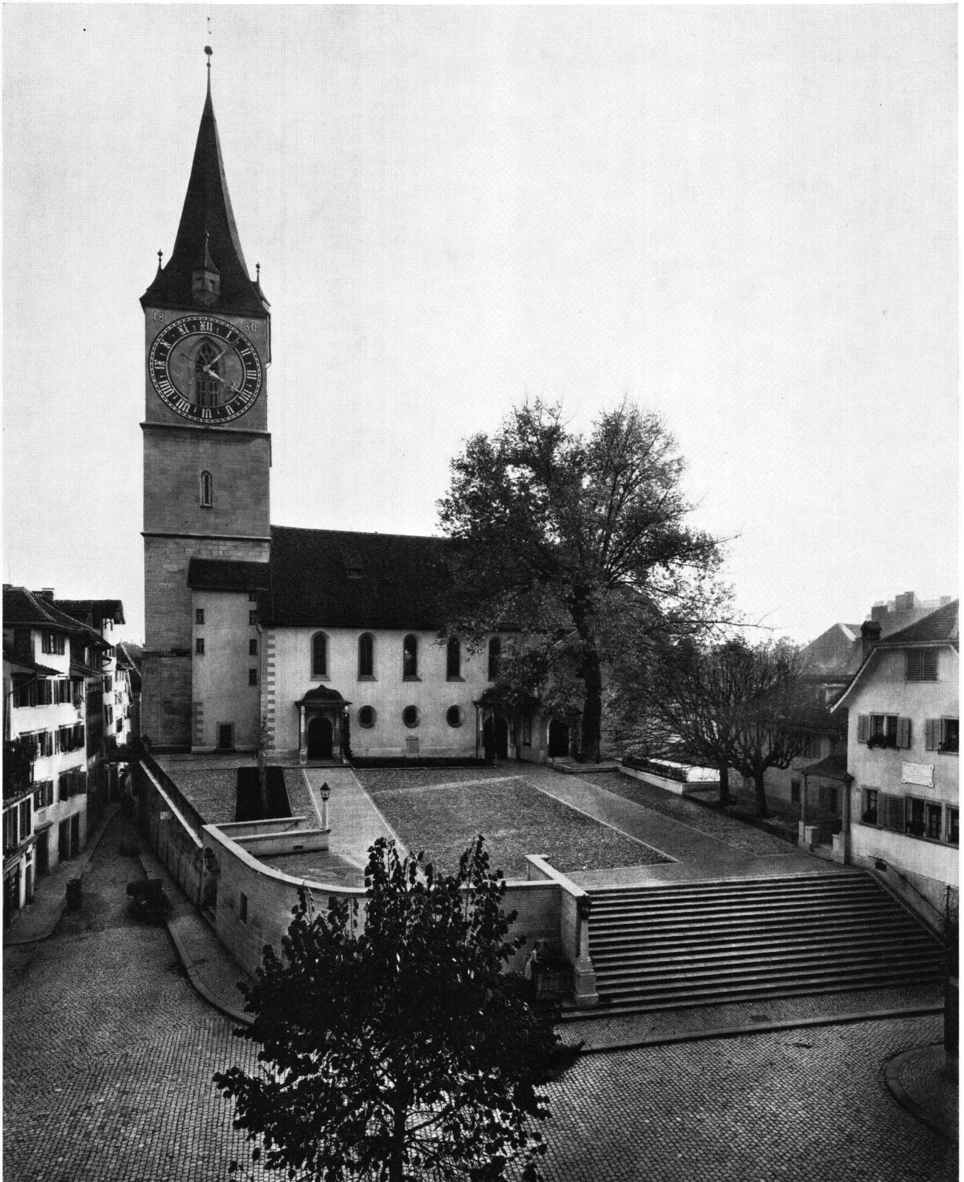
Abb. 49 Dieses Archivbild von St. Peter wurde kurz nach 1909 gemacht und zeigt – von kleinen Veränderungen abgesehen – den baulichen Zustand bis zur Restaurierung
