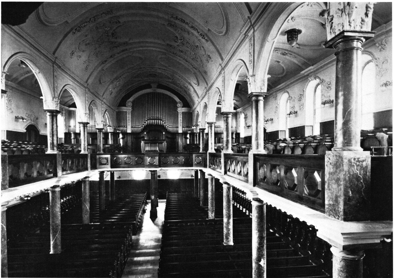
Abb. 43 Der Innenraum vor der Restaurierung. Vier Fenster unter den Seitentonnen wurden von der Orgel verdeckt
