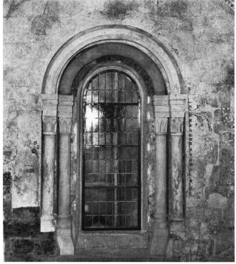
Abb. 12 Restauriertes Ostwandfenster mit den ergänzten hinteren Säulchen
