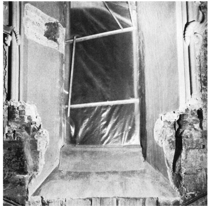
Abb. 11 Ostwandfenster. Unter der barocken Verkleidung der spätromanischen Fensterleibung kommen die ursprünglichen Säulchen zum Vorschein. Die hinteren Säulchen wurden allerdings bei der Barockisierung bis auf kümmerliche Basenstümpfe weggeschlagen (vgl. dazu Abb. 1 auf Tafel III)
