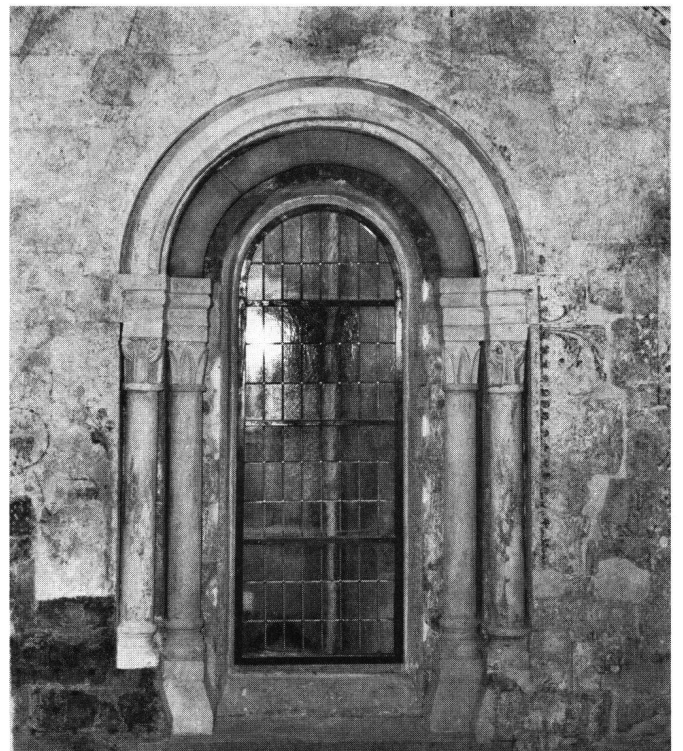
Abb. 12 Restauriertes Ostwandfenster mit den ergänzten hinteren Säulchen
