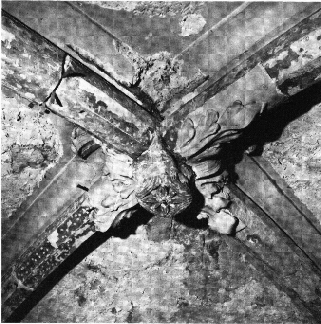
Abb. 9 Chorgewölbe. Unter der barocken Stuckverkleidung von 1705 befinden sich die spätromanischen Kreuzrippen mit dem quadratischen, leicht abhängenden Schlußstein (vgl. Abbildung 10)
