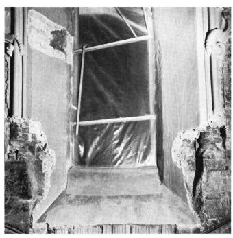
Abb. 11 Ostwandfenster. Unter der barocken Verkleidung der spätromanischen Fensterleibung kommen die ursprünglichen Säulchen zum Vorschein. Die hinteren Säulchen wurden allerdings bei der Barockisierung bis auf kümmerliche Basenstümpfe weggeschlagen (vgl. dazu Abb. 1 auf Tafel III)
