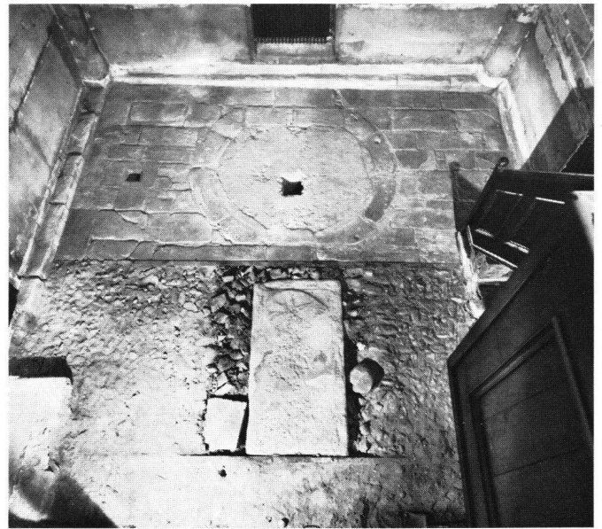
Abb. 22 Taufsteinfundament aus nachreformatorischer Zeit. Das Plattenrund ist als Auflager für ein wohl einstufiges Podest, auf welchem der Taufstein stand, zu deuten. Im Vordergrund die Grabplatte Bürgermeister Bruns († 1360)
