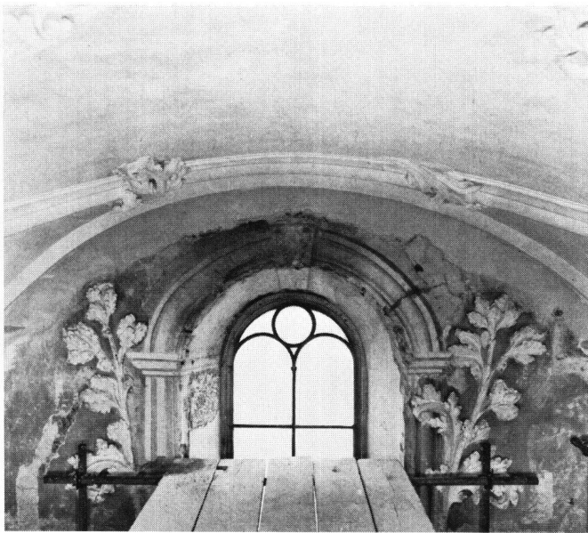
Abb. 24 Südlichstes Fenster der Westfront. Unter dem barocken Stuck kommt Architekturmalerei mit Kämpfer und Schlußstein zum Vorschein
