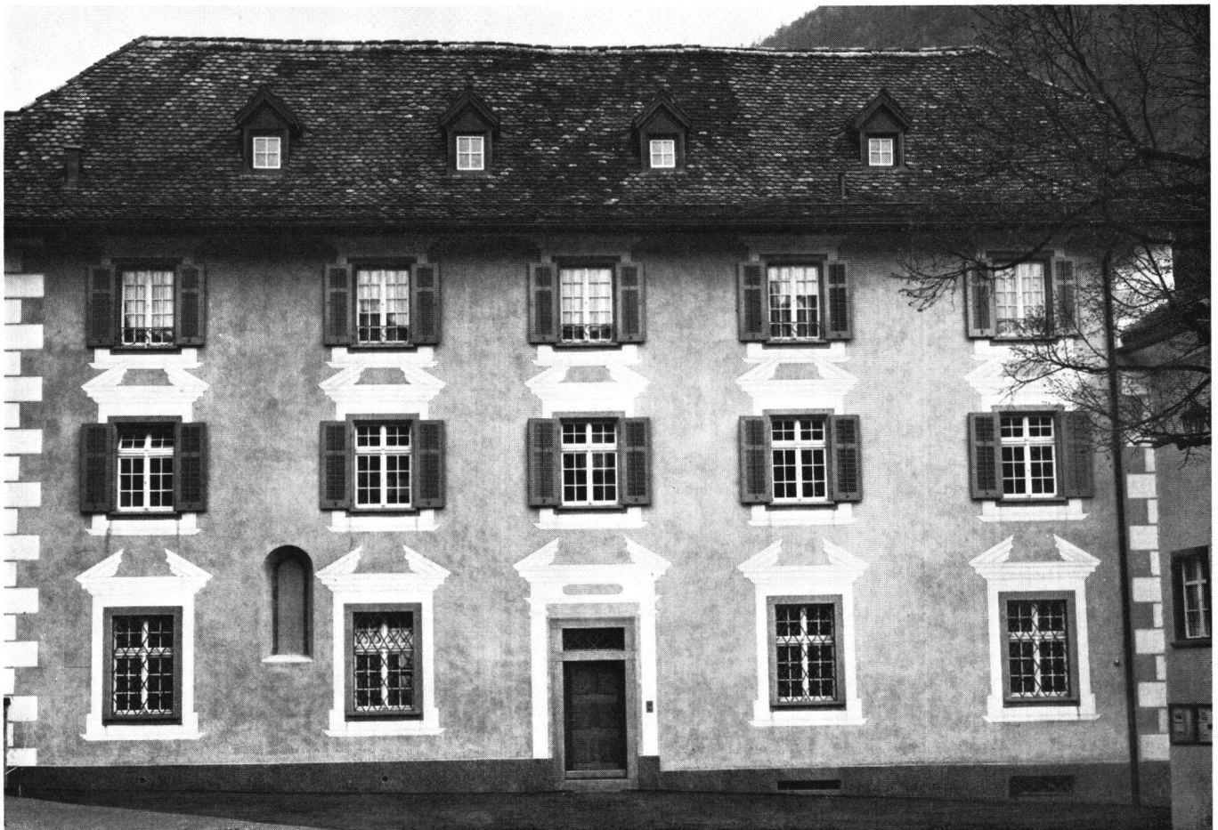
Abb. 1 Domschulhaus, Nordfassade mit wiederhergestelltem Dekor, Mitte 17. Jahrhundert. Links frühgotisches Fenster der ehemaligen Florinuskapelle
