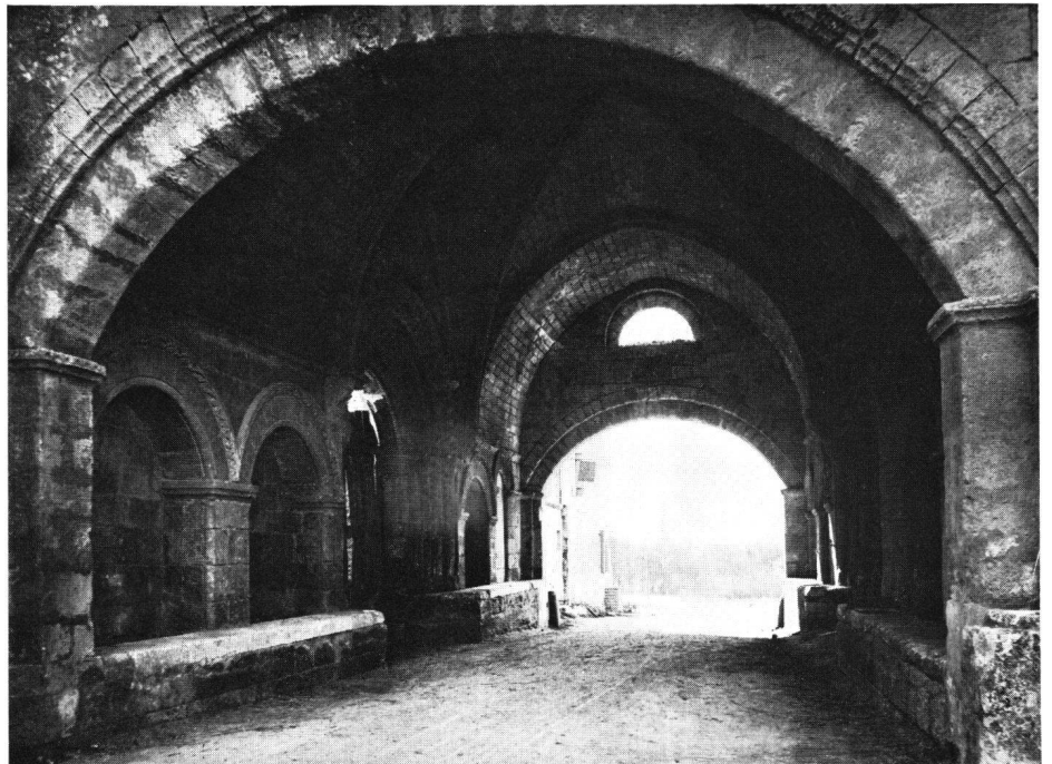
Fig. 16 Le passage routier de l'ancien hôpital de Pons en Saintonge, en 1877 (Photo Caisse nationale des Monuments historiques, Paris)
