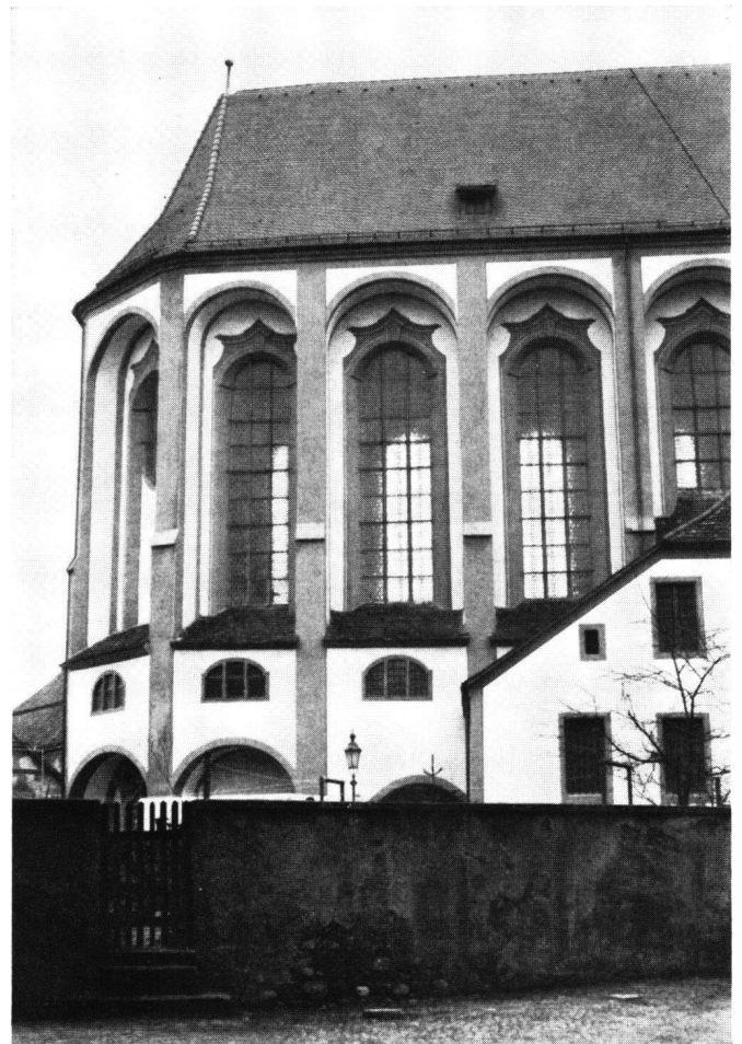
Abb. 17 Der Chor von Norden, Aufnahme 1975
