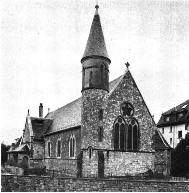
Fig. 16 Street: L'église anglaise de Vevey, bâtie en 1880. Façade et côté septentrional
