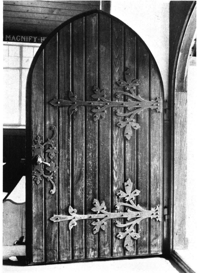
Fig.14 Street: L'église anglicane de Mürren, bâtie en 1878. Portail
