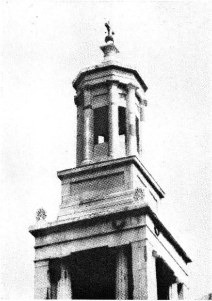
Abb. 17 Francis Bedford (1784–1858): Kirche Holy Trinity, Southwark, London, erbaut 1823–1824. Turmaufbau
