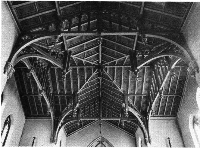
Abb. 4 Lichtensteig, ehemalige Pfarrkirche. Deckenkonstruktion
