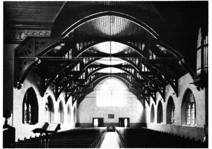
Abb. 7 Luzern, St. Mark's Church. Innenansicht gegen Westen
