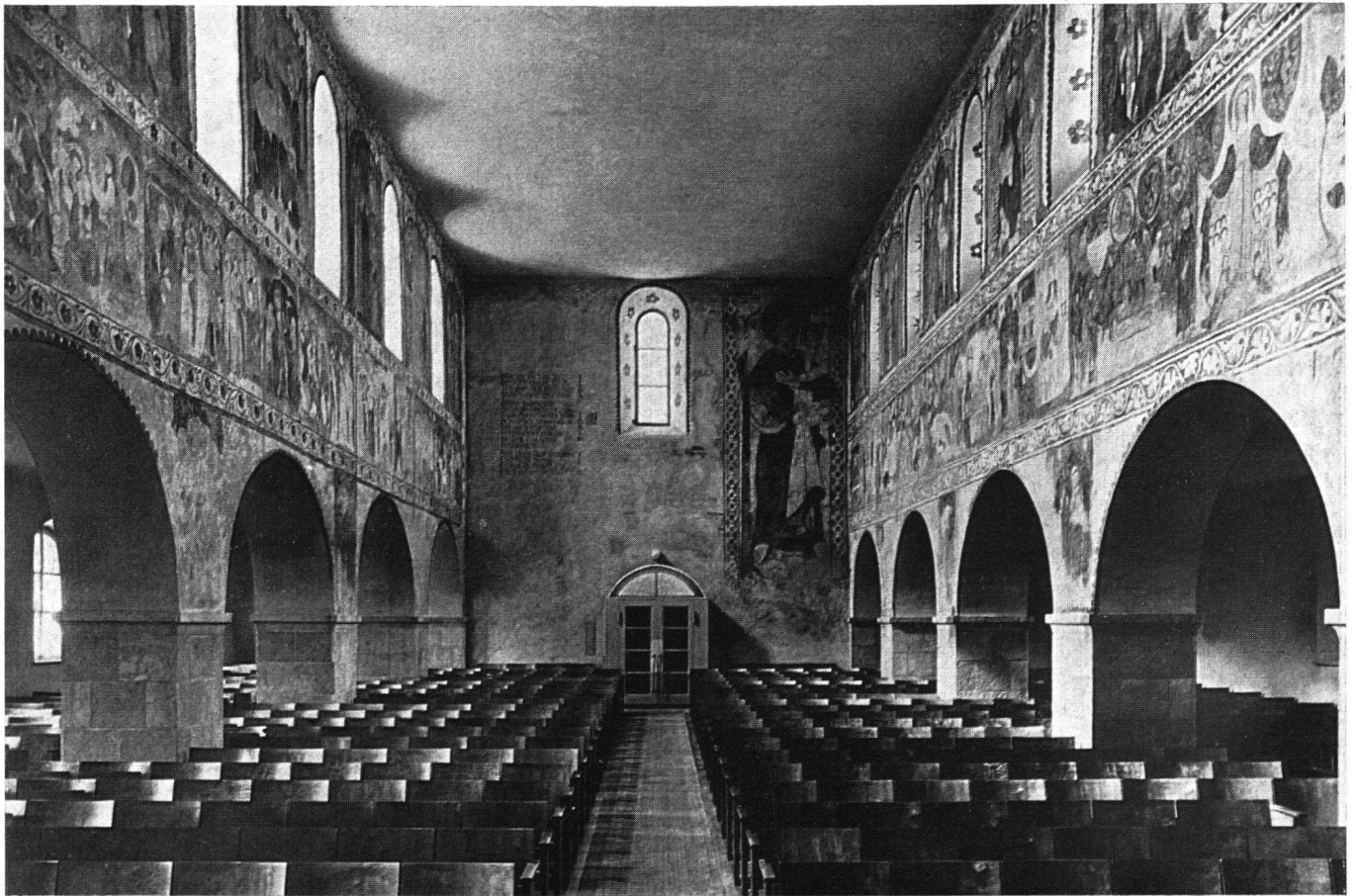
Abb. 3 Oberwinterthur, Kirche St. Arbogast: Innenansicht mit Blick nach Westen
