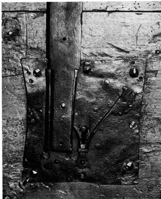
Abb. 5 Schloß einer spätgotischen Pfostentruhe (im Schweizerischen Landesmuseum, LM 17485). Viereckige, eiserne Schloßplatte (16 × 16 cm) mit eingerastetem Schließbügel. Ein ähnliches Schloß mag die Truhe von 1449 ursprünglich aufgewiesen haben
