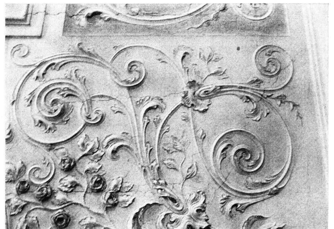
Abb. 18 Stans, Regierungsgebäude. Detail der Stuckdecke im 1. Stock (vgl. den Mittelspiegel an der Decke des Schiffs in der Jesuitenkirche in Pruntrut, Abb. 28)
