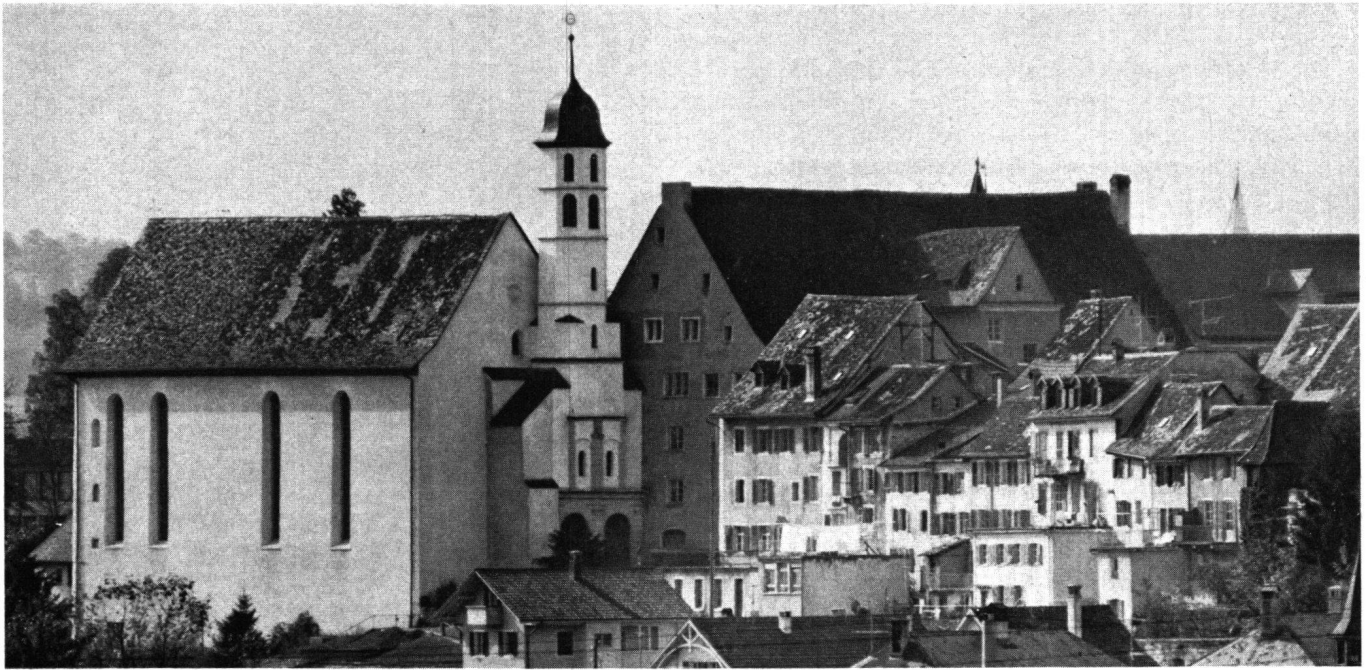
Abb. 7 Pruntrut, Jesuitenkirche und Kollegium. Ansicht von Nordosten (1968)
