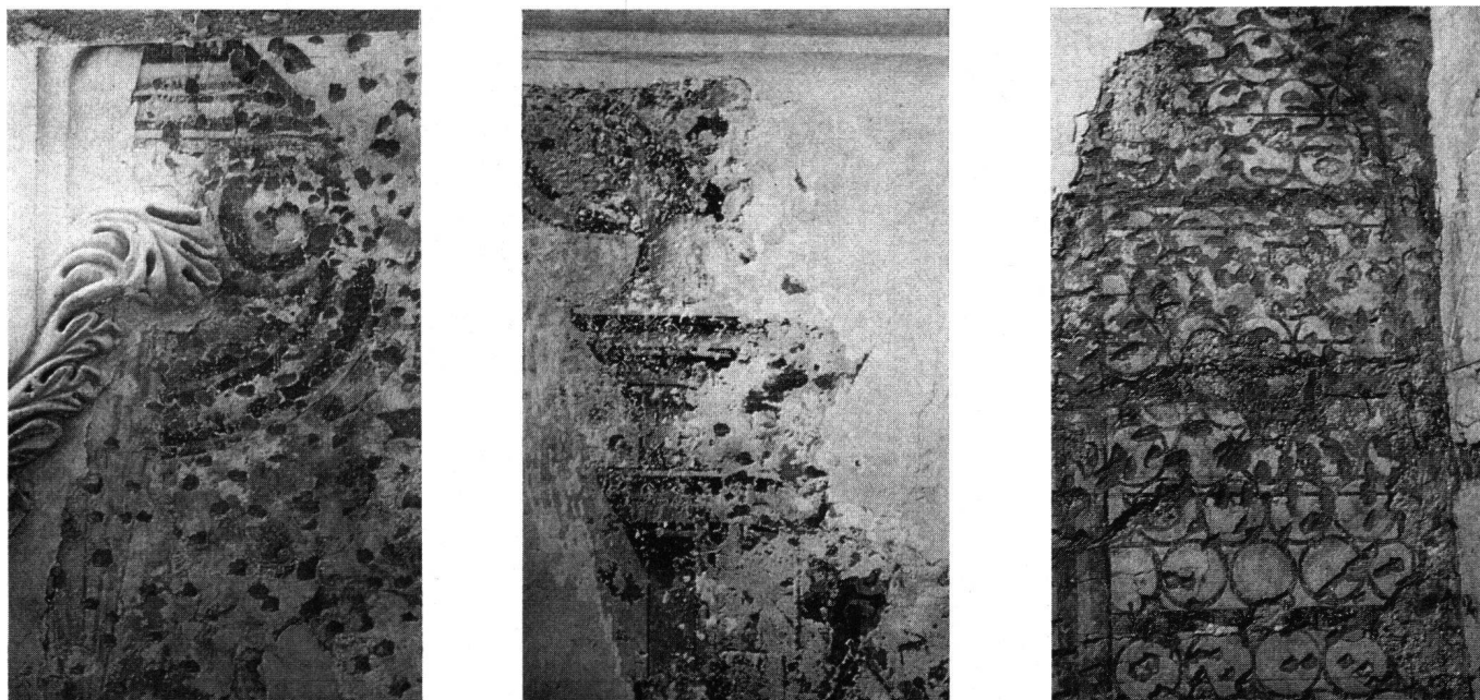
Abb. 10, 11 Pruntrut, Jesuitenkirche. Farbige Einfassungen der Fenster- und Türöffnungen mit Scheinarchitektur und Früchtegehängen im nachgotischen Bau. – Eines der blinden Fenster der Südseite, als Nische ausgebildet, ausgemalt mit Mittelgewände, Maßwerk und Bleiverglasung
