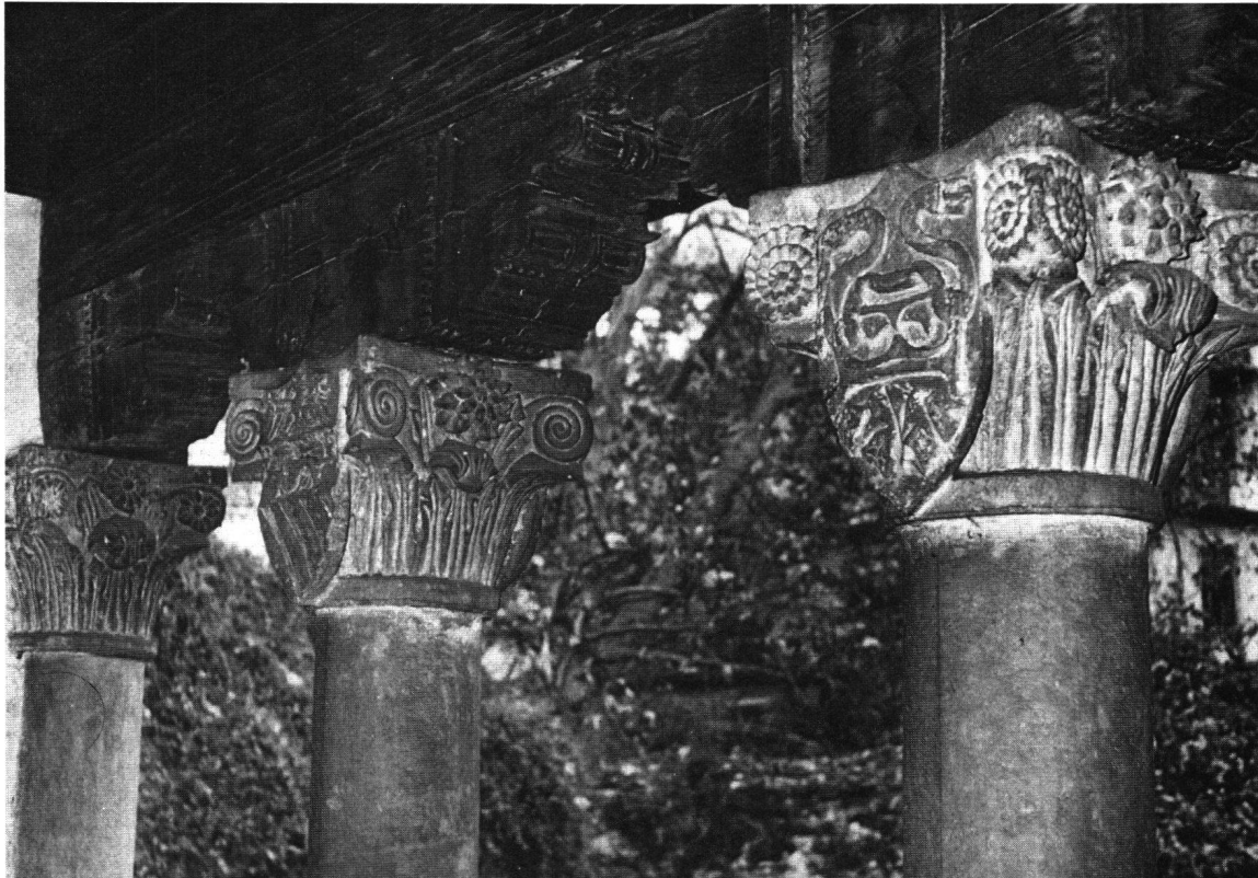
Abb. 5 Kapitelle in der Loggia des ersten Stockwerks, um 1451/66 (?). Anlässlich der Restaurierung von 1923–26 wohl überarbeitet. Links Wappen Rusca, rechts Emblem der Rusca mit Steigeisen
