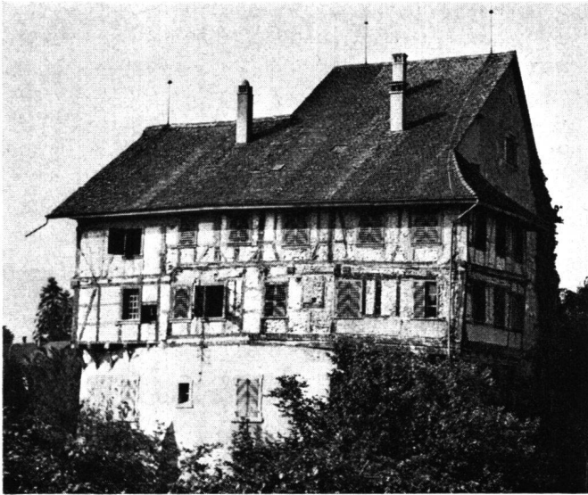
Abb. 16 Zug, Burg. Zustand nach Freilegung des Riegelwerks 1967. Blick von Norden gegen die Schildmauer und den habsburgischen, später erhöhten Riegelbau
