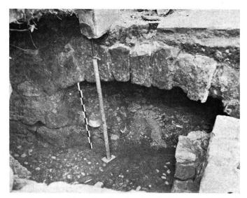
Abb. 29 Burg Zug. Ostseite der Steinbrücke von 1550 mit später eingeführtem Bachbett in Bollensteinpflästerung
