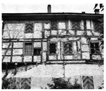
Abb. 17 Zug, Burg. Zustand nach Freilegung des Riegelwerks 1967. Blick von Norden gegen die Schildmauer und den darauf gesetzten Riegelbau in seinen einzelnen Bauphasen
