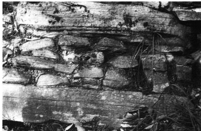
Abb. 17 Castello di Tegna. Bindesteine in der westlichen Stützmauer (unter Kote 494, vgl. Abb. 16)
