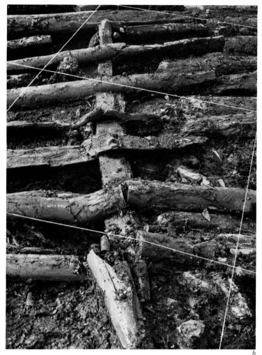
Thayngen-Weier III. Haus  $\mathcal{J}$ . a Bretterboden, von Osten. Grundrissplan III/C. b Unterzug mit Prügelrost, Felder 97 und 98, von Süden. Grundrissplan III/B.
