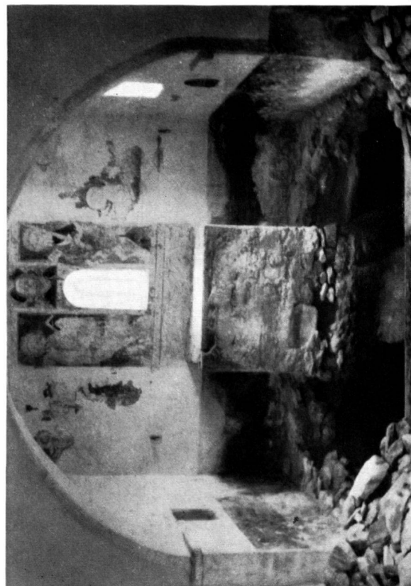
a-d Inneres der Kirche St. Lorenz bei Paspels: a, b Nord-, bzw. Süd- und Gewölbeansätzen des vorromanischen Baus. c Nordwand, Fundamentierung des Wandpfeilers, d Chor mit freigelegtem Blockaltar. Zustand der Wände vor Freilegung der romanischen Malereien.
