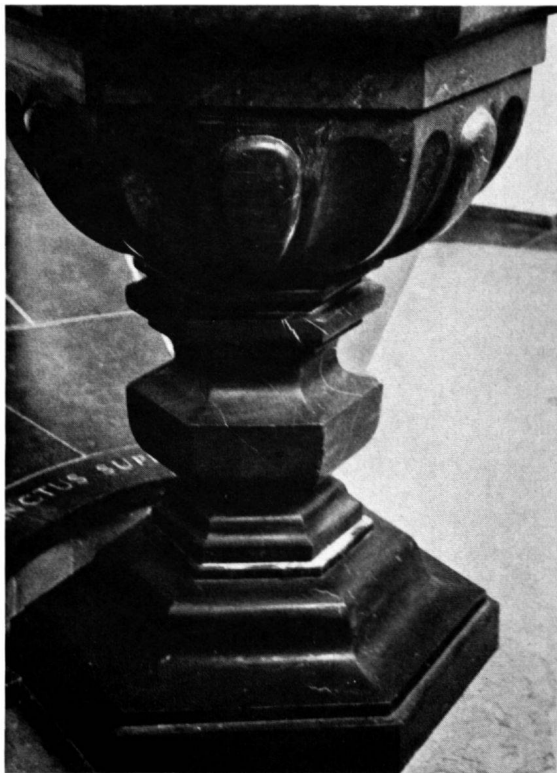
a Vorhalle der barocken Kapelle in Tammatten bei Saas Grund. Säulen aus grober Rauhwacke. b Taufstein in der Kirche Sursee, um 1640. Schwarzer Marmor (dunkler, polierter Alpenkalkstein), hier mit deutlicher Brekzienstruktur. c Grabmahl von Erlach in der Kirche Schinznach Dorf, um 1650. Der helle Alabaster an Kapitell und Plastik wirkungsvoll mit den Säulen aus dunklem Alpenkalkstein kontrastierend.
