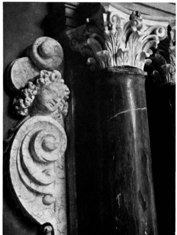
a Vorhalle der barocken Kapelle in Tammatten bei Saas Grund. Säulen aus grober Rauhwacke. b Taufstein in der Kirche Sursee, um 1640. Schwarzer Marmor (dunkler, polierter Alpenkalkstein), hier mit deutlicher Brekzienstruktur. c Grabmahl von Erlach in der Kirche Schinznach Dorf, um 1650. Der helle Alabaster an Kapitell und Plastik wirkungsvoll mit den Säulen aus dunklem Alpenkalkstein kontrastierend.
