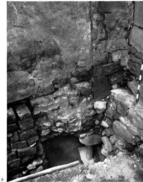
a–d Pfarrkirche von Tuggen (Kt. Schwyz): a, b Überreste der teilweise als Fundament dienenden, 1940 grossenteils abgebrochenen Südmauer eines Anbaues der romanischen Kirche ( a Gesamtansicht der Mauerpartie östlich des Turmes vor dem Abbruch von 1940, b nach dem Abbruch von 1940, aufgenommen anlässlich der Nachgrabung von 1958); zu Seite 167 f. – c Südwand des Presbyteriums mit den freigelegten Bauresten ( a Fundament der romanischen Südmauer, b romanischer Verputz, c gotischer Verputz, d Westgewände der gotischen Turmtür, d' gotischer Tonplattenboden, e Türschwelle des barocken Turmeingangs). – d Turm mit spätgotischen und barocken Schalllöchern, darüber (in der 1959 aufgestockten Zone) die Zifferblätter und das neue Kupferdach; zu Seite 177.
