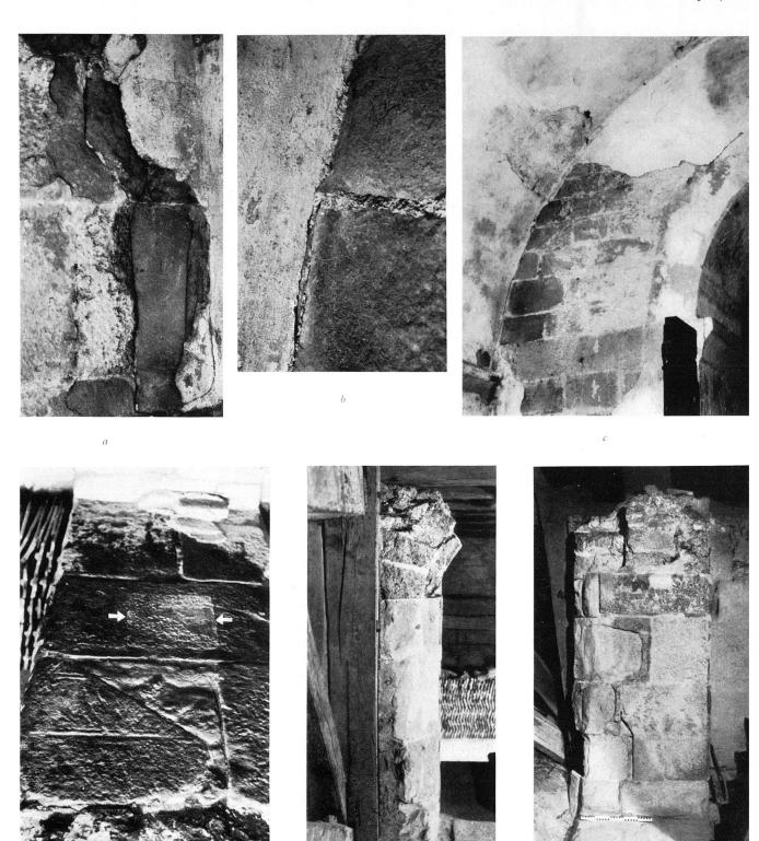
a Innere NW-Ecke im Erdgeschoss des Südturms mit eingemauertem Wandsockel. – b Einzelheit aus c mit Baufuge. – c Erd geschoss des Südturms: In Bauzeit 5 eingesetzte Westmauer mit Eingang vom Querschiff her. – d Glockengeschoss des Südturms. Ban des Nordfensters mit Standspur einer Fenstersäule (durch Pfeile bezeichnet). – e Östliches Gewände dieses Fensters von aussen.
