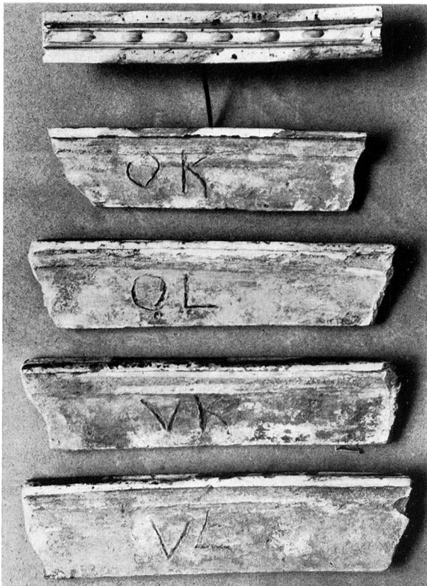
2 Zwei Eierstäbe mit glasiertem geradem Abschluss auf einem Ende – 3 Zwei Eierstäbe mit glasiertem pfeilförmigem Abschluss auf einem Ende – 4 Eierstäbe mit den vier vorkommenden Bezeichnungen – 5 Verkröpfungen des Turmsockelgesimses mit eingeritzten Ziffern auf dem Steg
