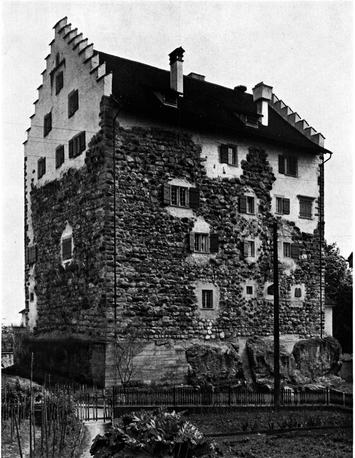
38 Das Schloss nach der Restauration von Norden gesehen, wo Felssockel zurückgewittert, schlichte Vormauerung als neue Zutat, in der Mitte Aussparung, herrührend von Abortfalleitung
